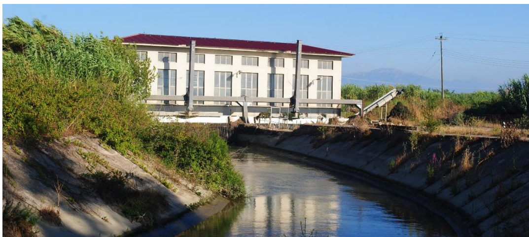
Εικόνα 27 Φωτογραφία από την πίσω πλευρά του Αντλιοστασίου Βίγλας.
