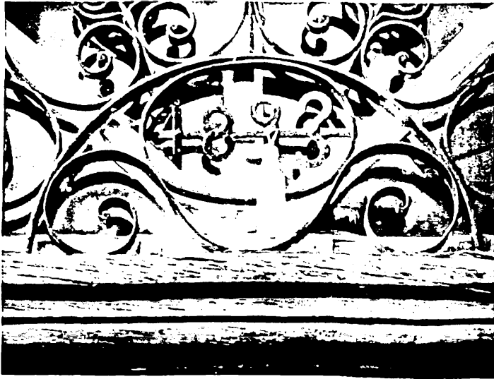
Εικ. Η16: Νεοκλασική κατοικία στο Καϊμακλί (Λευκωσία). Στη σιδεριά, που κλείνει το φεγγίτη της εισόδου του εγκαταλελειμμένου σήμερα σπιτιού, παραμένει ακόμη δεμένο το μπουκαλάκι με τον αγιασμό, μέσο φύλαξης του κατώφλιού.
