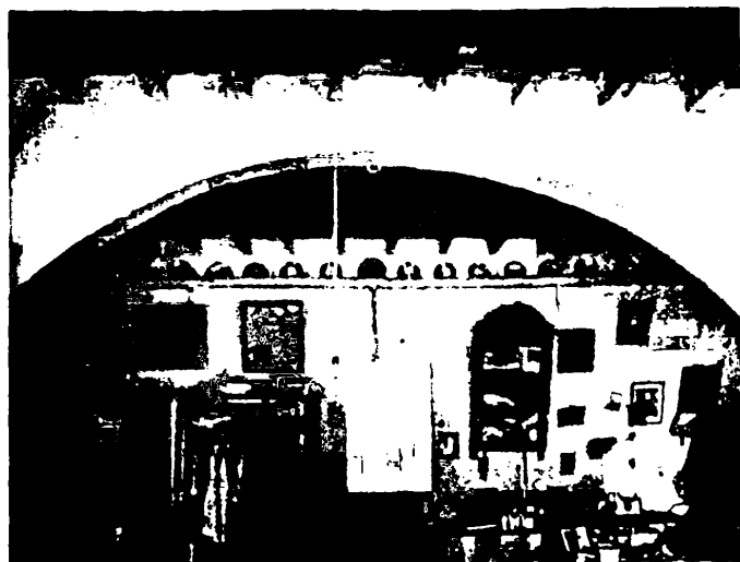
Εικ. Α2: Θεοδοσίου 8, Λιοπέτρι (Αμμόχωστος). Ημικυκλική (μονομούρελλη) καμάρα στο δίχωρο.
