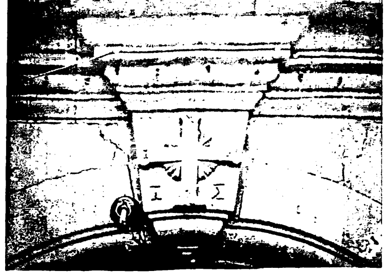
Εικ. Δ45: Λέσβου 3, Καϊμακλί (Λευκωσία). Ανάγλυφη παράσταση σταυρού στο κλειδί εισόδου νεοκλασικής κατοικίας. 1909
