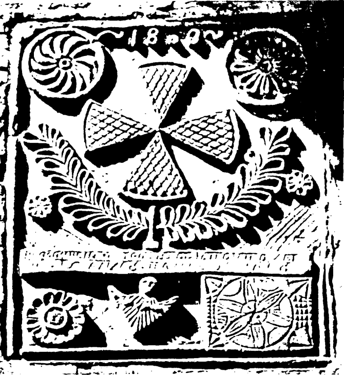
Εικ. Δ11: Νικ. Χριστοφίδη 15, Πέρα Ορεινής (Λευκωσία). Ένθετο λιθόγλυπτο πάνω από το υπόρτι, με παράσταση σταυρού, ροδάκων, τριβυλιόροδακα και χερουβίμ. Η επιγραφή αναφέρει: «ΕΓΚΟΔΟΜΗΘΗ Ο ΛΙΘΟΣ ΟΥΤΟΣ ΥΠΟ ΥΠΟ ΧΕΙΡΟΣ ΙΩΑΝΝΗΣ ΠΑΠΑΔΟΠΣΛΛΣ», 18(;)0
