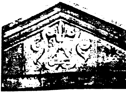
Εικ. ΣΤ52: Αρχ. Φιλοθέου 18, Λευκωσία. Ανάγλυφη παράσταση κρίνου και ελίκων στο τύμπανο του αετώματος παραθύρου.
