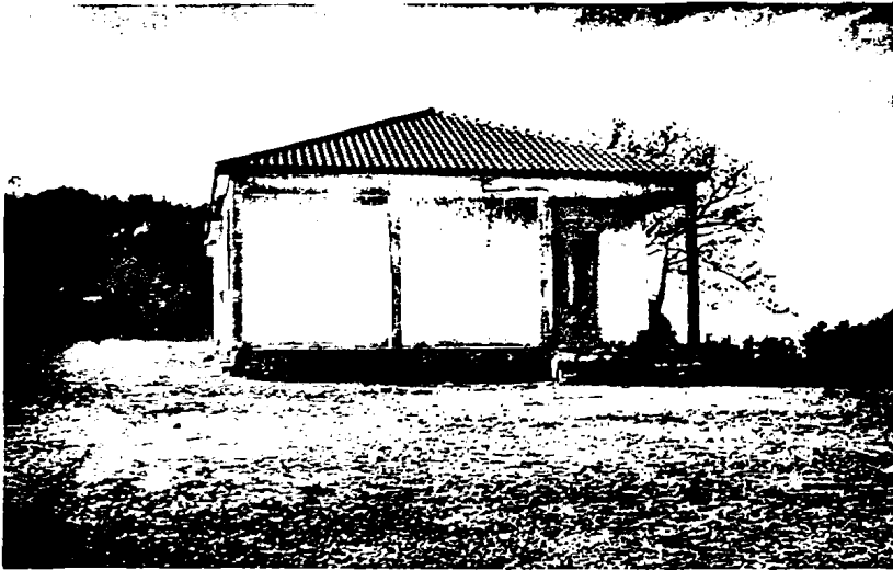
Το εγκαταλειμμένο καινούριο κτίριο του σχολείου
