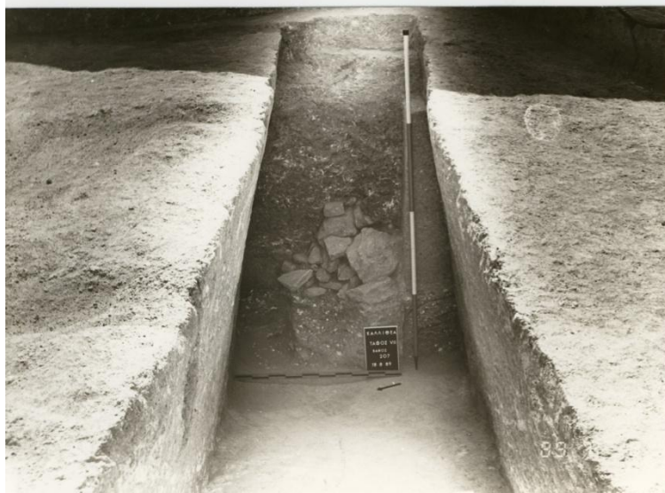
ΤΑΦΟΣ VII: Δρόμος, πρόσοψη και είσοδος
