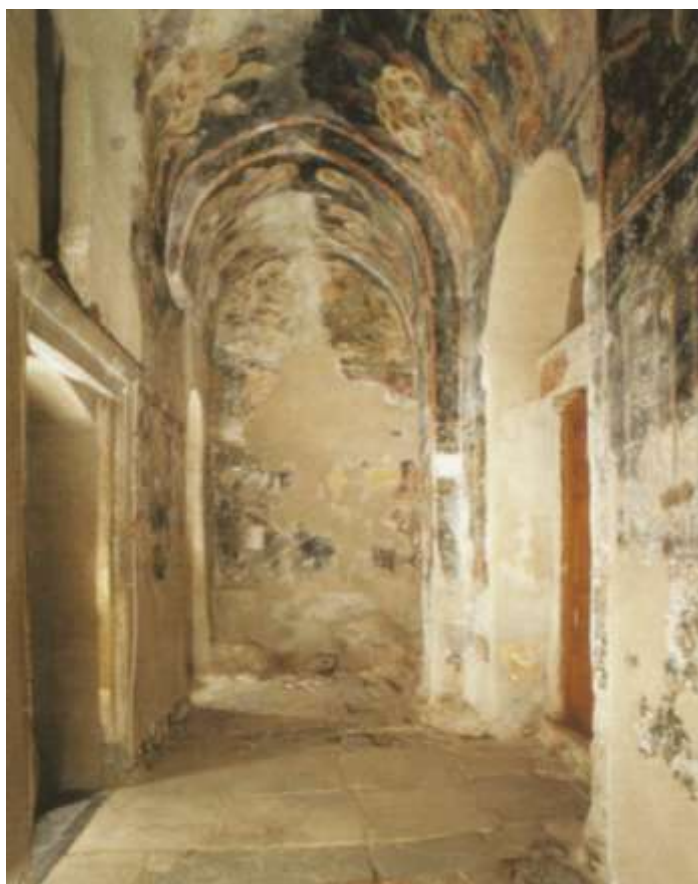
Εικόνα 18. Ναός αγίου Δημητρίου της καστροπολιτείας του Μυστρά. Εσωτερική άποψη του νάρθηκα προς Νότια. (Προσωπικό Αρχείο)
