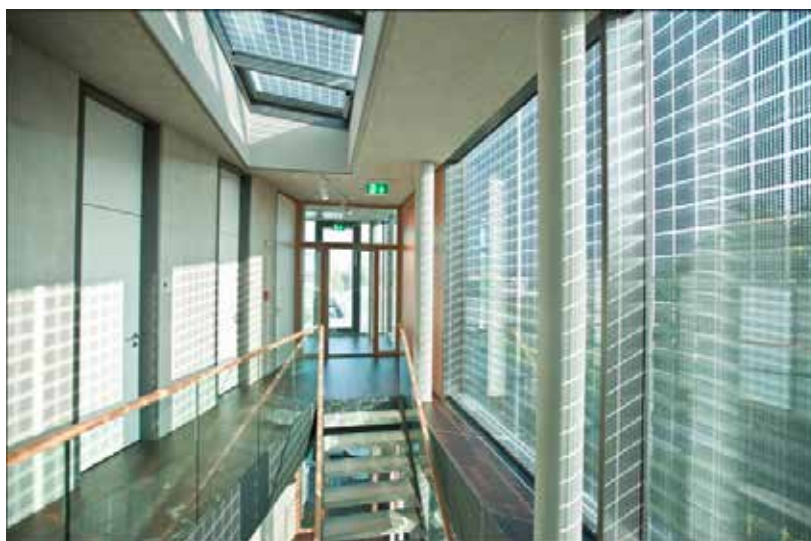
Εικόνα 5.5 Εφαρμογή ημιδιαφανών ηλιακών κυττάρων Si για παραγωγή ενέργειας αλλά και φυσικό ομοιόμορφο φωτισμό
