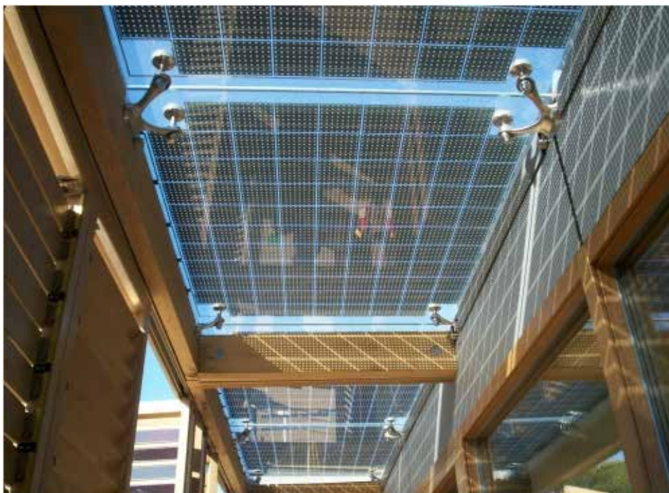
Εικόνα 1.1 Παράδειγμα εγκατάστασης ημιδιαφανών φωτοβολταϊκών κυττάρων προς εκμετάλλευση του φυσικού φωτισμού παράλληλα με την παραγωγή ενέργειας.
