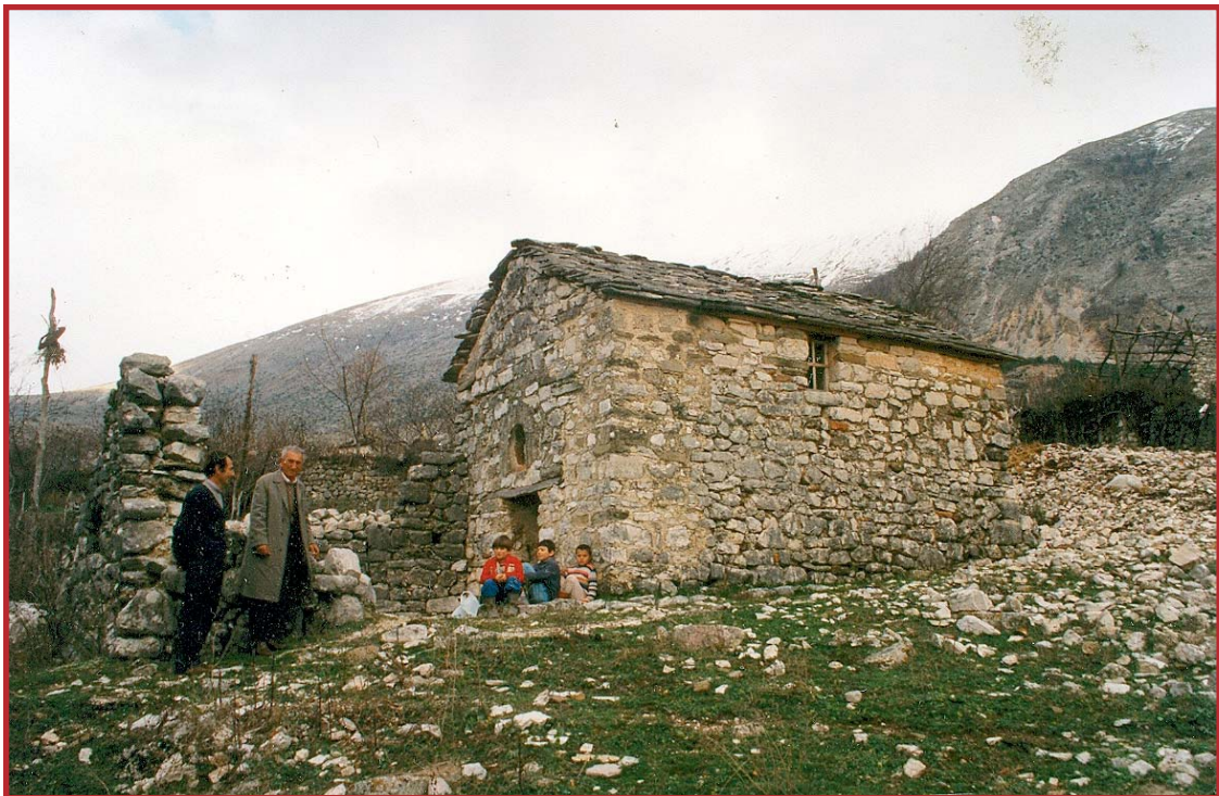
1. Ι.Ν. Αγ. Δημητρίου Σάββου. Νότιο δυτική όψη.
