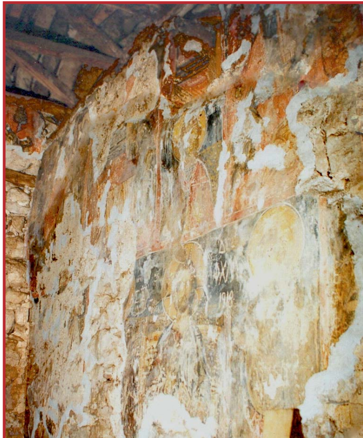
72. Ι.Ν. Αγ. Δημητρίου Σάββου. Εσωτερικό, νότιος τοίχος.
