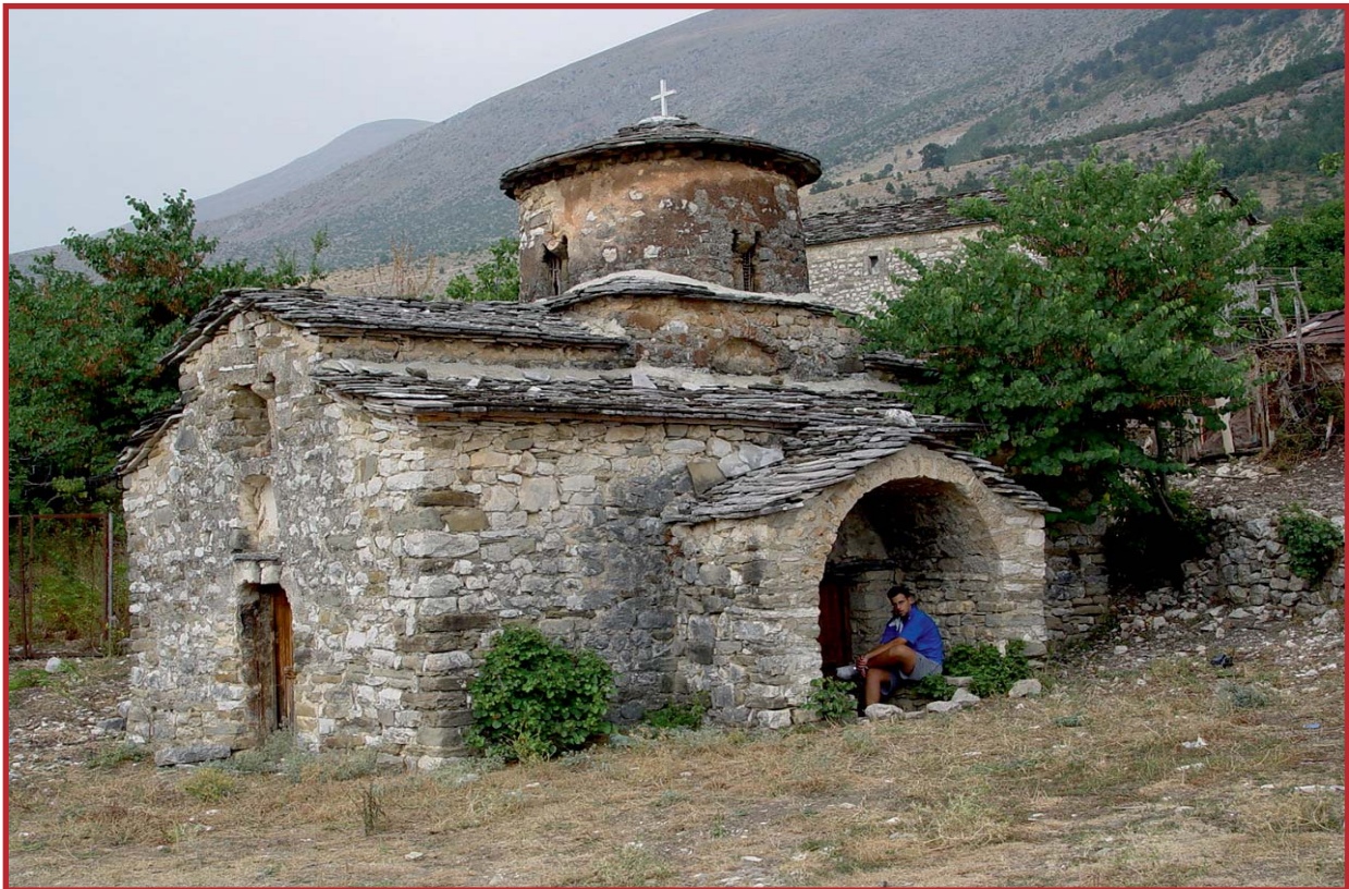
1. Ι.Ν. Αγ. Αθανασίου Μάτζαρη. Νοτιοδυτική όψη.
