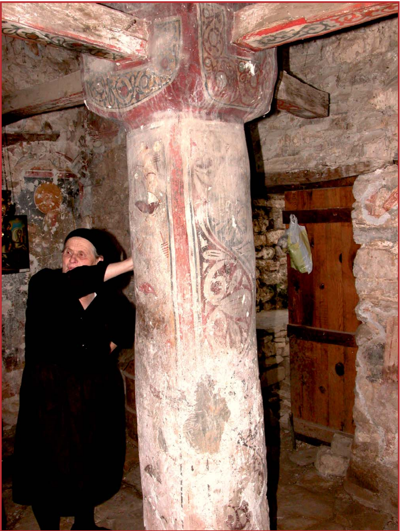
131. Πολίτσιανη, Ι.Ν. Αγ. Αθανασίου Μάτζαρη, κυρίως ναός. Μονόλιθος κίονας (σε δεύτερη αρχιτεκτονικά χρήση) με γραπτό διάκοσμο.
