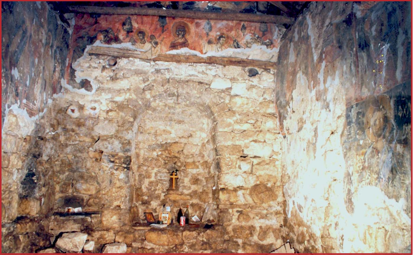
71. Ι.Ν. Αγ. Δημητρίου Σάββου. Εσωτερικό, ανατολική άποψη.
