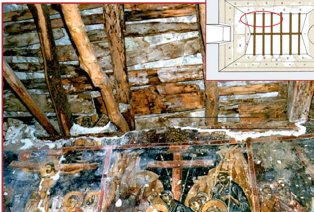
11. Ι. Ν. Αγ. Δημητρίου Σάββου. Αποψη της (ξυλόστεγης τώρα) οροφής στον κυρίως ναό.
