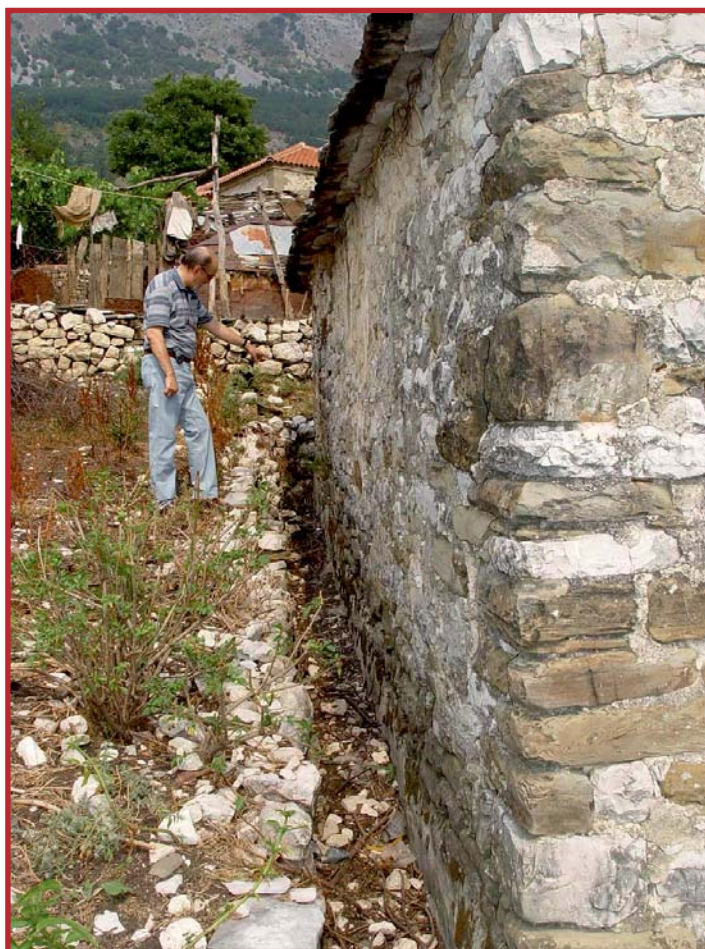
10. Πολίτσιανη, Ι.Ν. Αγ. Αθανασίου Μάτζαρη, βορειοδυτική όψη. Στον βόρειο τοίχο παρουσιάζονται εμφανώς σπαράγματα παλαιάς ζωγραφικής διακόσμησης.
