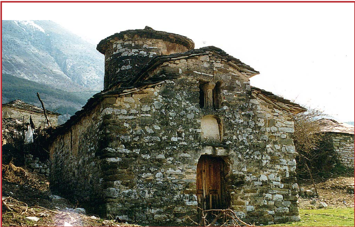
2. Ι.Ν. Αγ. Αθανασίου Μάτζαρη. Βορειοδυτική όψη
