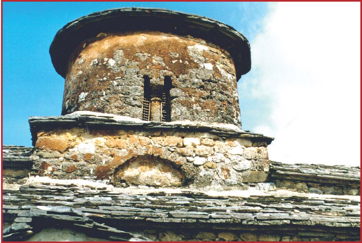
3. Ι.Ν. Αγ. Αθανασίου Μάτζαρη. Νότια όψη τρούλου και βάσης (εξάρματός) του.
