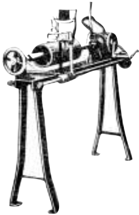
Εικ. 3.2: Η μηχανή φωτοευαίσθητης επίστρωσης που εφευρέθηκε από τον Ernst Rolffs.
