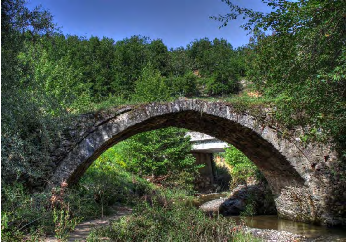
Εικόνα 31. Η γέφυρα της Γκουλιάμα ριάκας όπως διατηρείται σήμερα.
