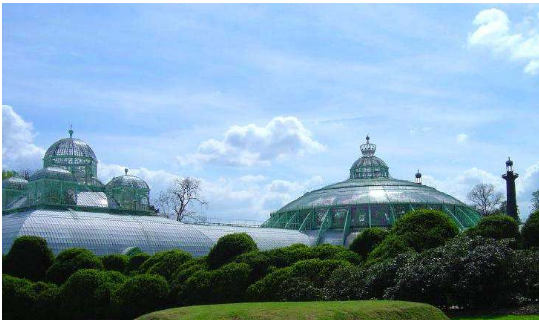
Σχήμα 2.3: Το σύμπλεγμα θερμοκηπίων Royal Greenhouses of Laeken στο Βέλγιο.
