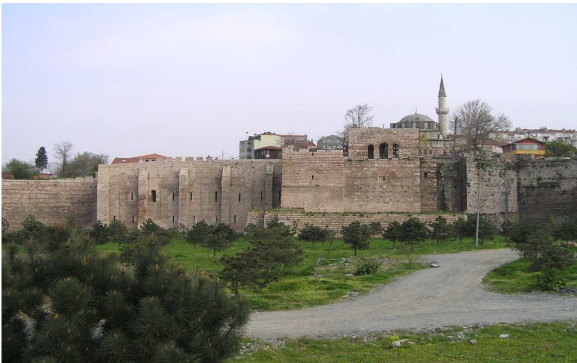
Εικ. 4. Κωνσταντινούπολη. Εξωτερική άποψη του τείχους των Βλαχερνών (Ayvansaray) ( http://commondatastorage.googleapis.com/static.panoramio.com/photos/original/9071014.jpg )
