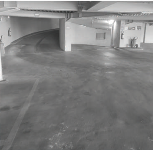
Εικόνα 12: Ράμπες πάρκινγκ β' ορόφου
