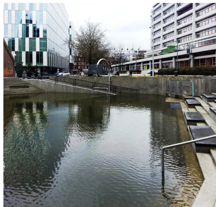
Εικ. 17 - Watersquare Benthemplein, Ρότερνταμ, DE URBANISTEN, 2013. Η λεκάνη λειτουργεί ως προσωρινός χώρος συλλογής και αποθήκευσης όμβριων υδάτων, μεταβάλλοντας τη λειτουργία της πλατείας ανάλογα με τις κλιματικές συνθήκες. Πηγή: DE URBANISTEN.
