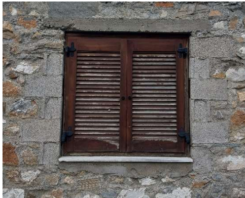
Εικόνα 13: Επιλεκτική χρήση σκυροδέματος στο πρέκι του παραθύρου αλλά και με την μορφή τσιμεντόλιθων στους λαμπάδες αντί των λαξευμένων φυσικών λίθων. (πηγή: Ιδία επεξεργασία)
