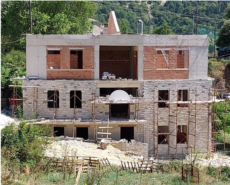
Εικόνα 57: Κατοικία στα Ζαγοροχώρια. Ο ιδιοκτήτης υποχρεούται να επενδύσει το κτίριο με λιθοδομή που να θυμίζει λαϊκή αρχιτεκτονική στα πλαίσια της προστασίας της αισθητικής του παραδοσιακού οικισμού. Η επένδυση είναι από κτιστή λιθοδομή, περίπου 10 εκατοστά, ο σκελετός είναι από οπλισμένο σκυρόδεμα ενώ οι τοίχοι πλήρωσης από οπτόπλινθους. Η λιθοδομή λειτουργεί ως «ρούχο» στο κτίριο.
