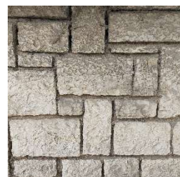
Εικόνα 39, από πάνω προς τα κάτω: Λιθοδομή του εσπατόριου-καφενείου στα Ιωάννινα του Α. Κωνσταντινίδη, 1971, Λιθοδομή του αρχαιολογικού μουσείου στα Ιωάννινα του Α. Κωνσταντινίδη, 1963-66, Λιθοδομή λαϊκής ηπειρωτικής αρχιτεκτονικής, πιθανόν 19 ος αιώνας, Επένδυση λιθοδομής σε βάση πολυκατοικίας στα Ιωάννινα, πιθανόν 1970-80. Παρατηρείτε τη χρήση ίδιου φυσικού λίθου με το παρελθόν αλλά με διαφορετική επεξεργασία και πλέξη στον 20 ο αιώνα. (πηγή: Ιδία επεξεργασία )
