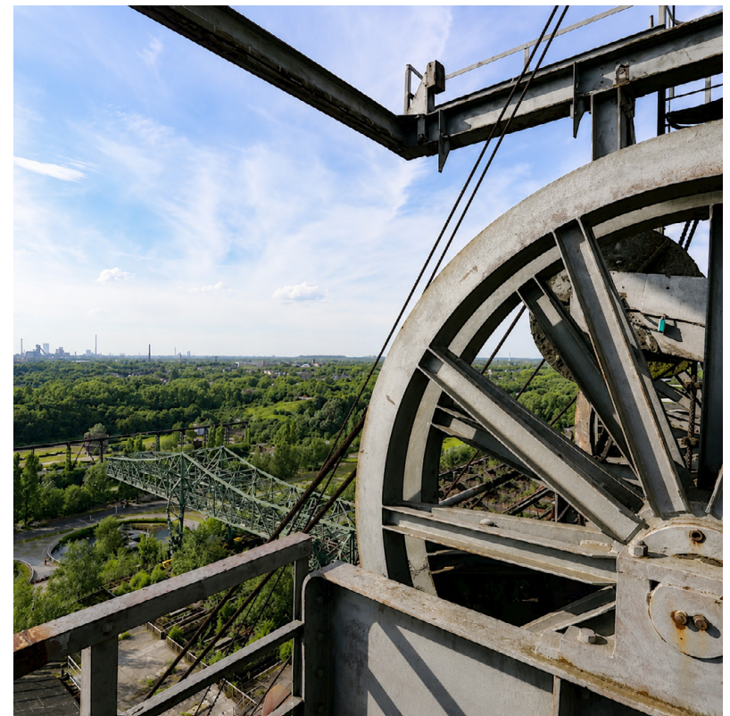
Μηχανισμός τροχαλίας στις μεταλλικές εγκαταστάσεις, Landschaftspark Duisburg-Nord, Γερμανία. Πηγή: landschaftspark duisburg-nord.
