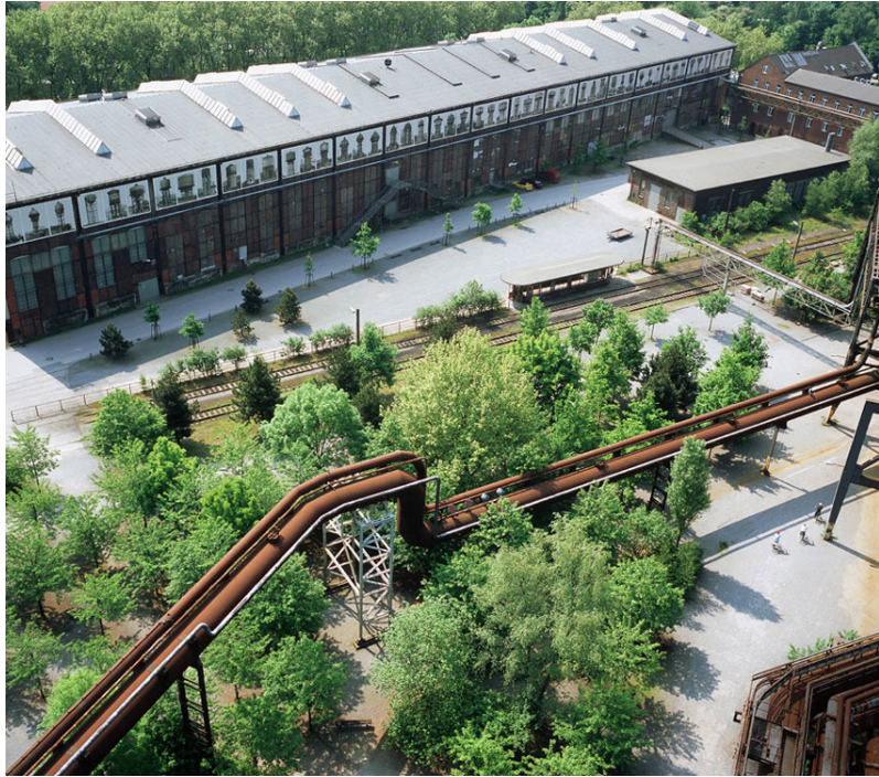
Βιομηχανικά κτίρια, αγωγοί και ζώνες βλάστησης, Landschaftspark Duisburg-Nord, Γερμανία. Πηγή: Landezine, Φωτογραφία: Αρχείο Latz + Partner.
