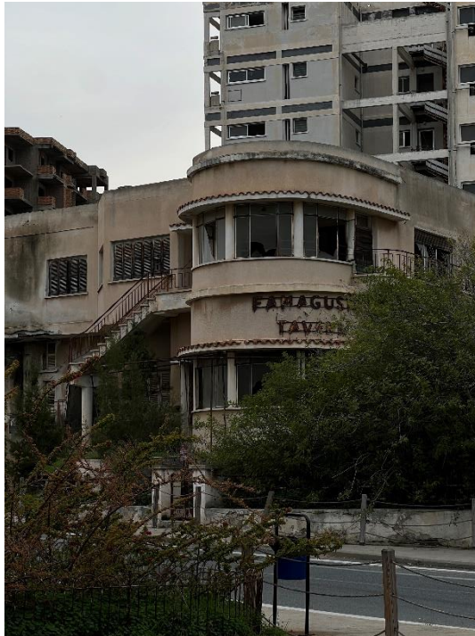
Εικόνα 5: Σύγχρονη άποψη εγκαταλελειμμένων κτιρίων στο Βαρώσι. Είναι εμφανής η εισβολή της βλάστησης στον αστικό ιστό και η εκτεταμένη διάβρωση των δομικών στοιχείων. (Φωτ. Ν. Ηρακλέους, 2025)
