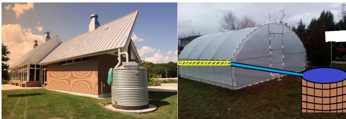
Σχήμα 1. Συλλογή βρόχινου νερού από την επιφάνεια της ταράτσας σε δεξαμενή στα αριστερά( www.verivox.de ), συλλογή βρόχινου νερού από την επιφάνεια θερμοκηπίου σε δεξαμενή ή πηγάδι χωραφιού (στα δεξιά) .
