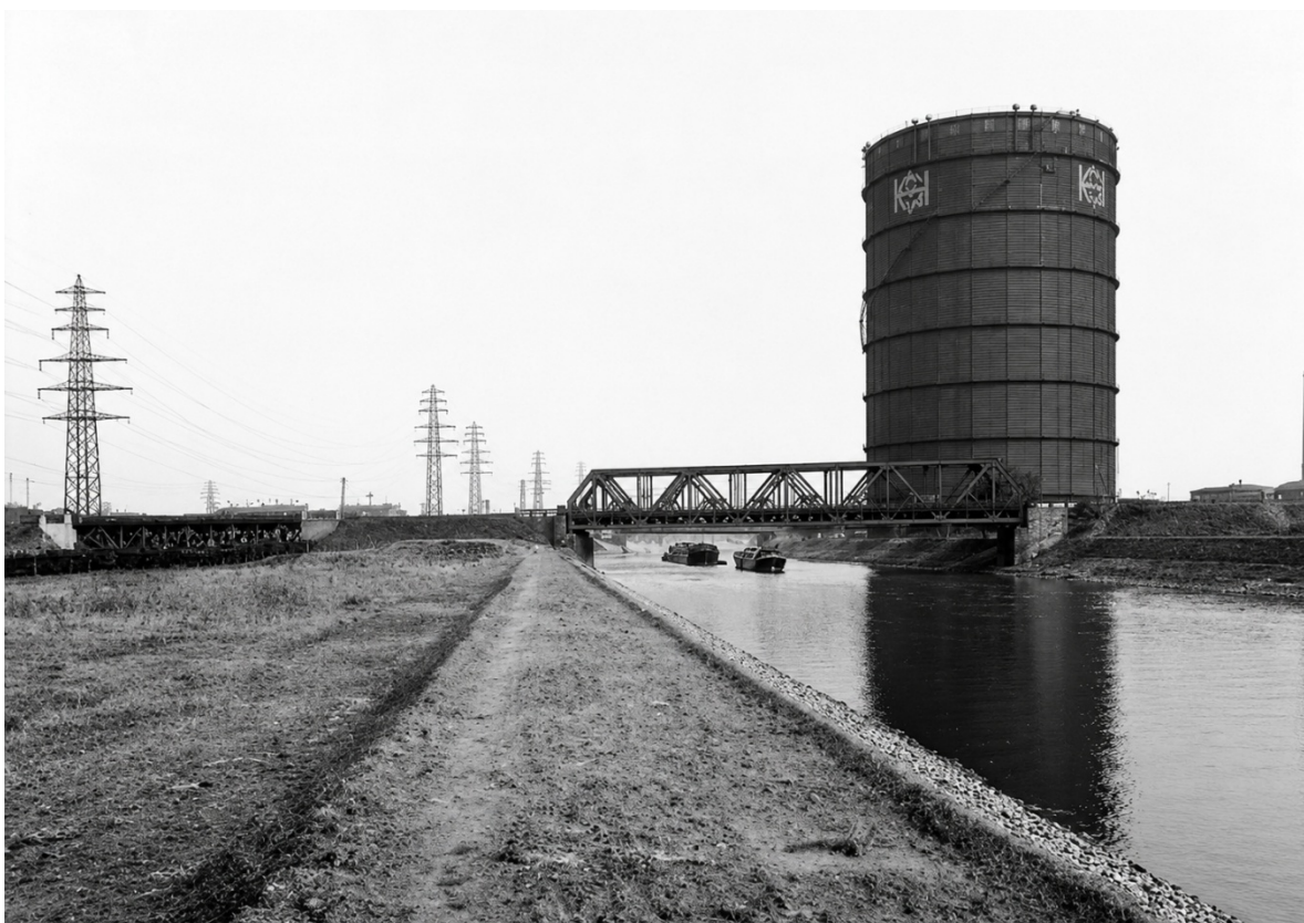
Εικόνα 15: Δεξαμενή αποθήκευσης αερίου, 1930, Ομπερχάουζεν.
