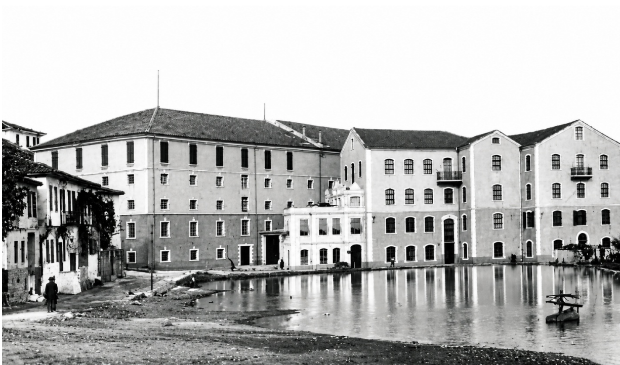
Εικόνα 12: Καπναποθήκη Σπίρερ, Δράμα.
