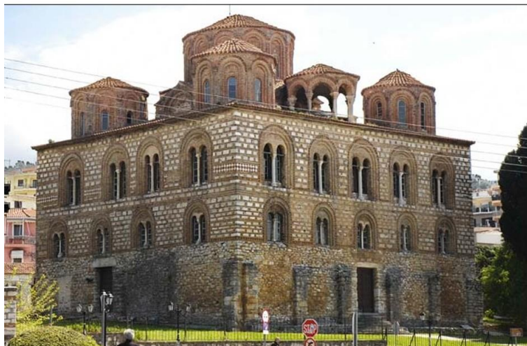
Εικόνα 14. Βορειοδυτική άποψη του καθολικού
