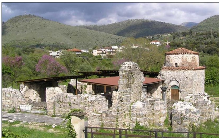
Εικόνα 21. Αποψη της σημερινής κατάστασης του καθολικού
