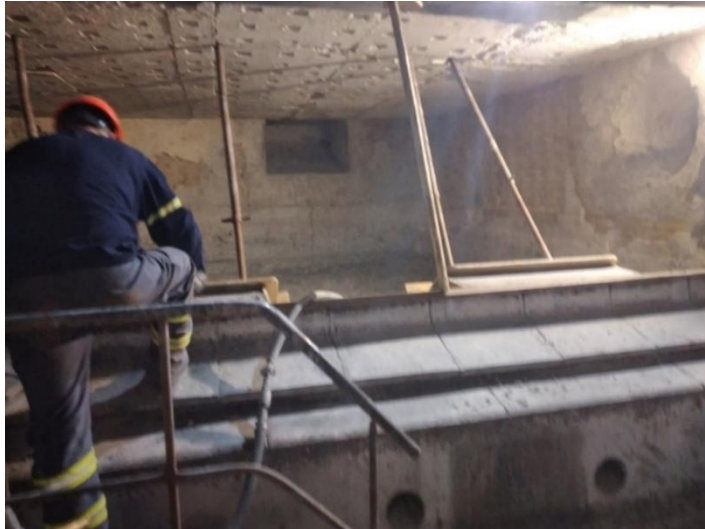
Εικόνα Π.12: Εφαρμογή πυρίμαχης μάζας MAT NANO 80AL/S.
