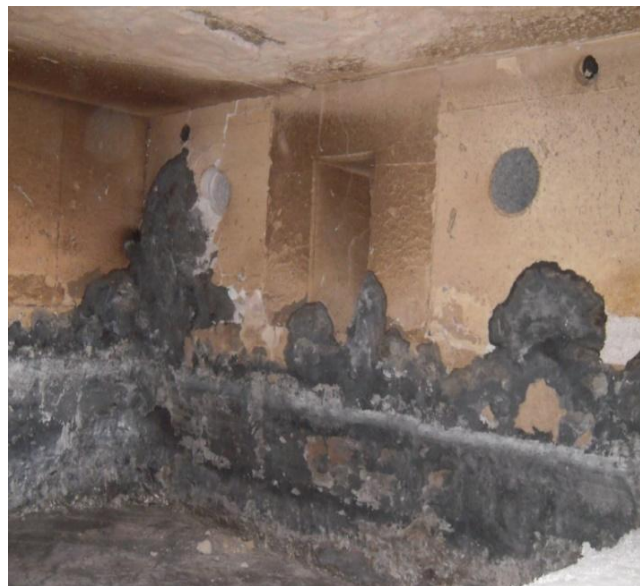
Εικόνα 2.8 (αριστερά): Μηχανισμός δημιουργίας δευτερογενούς κορουνδίου 87 , (δεξιά) Σχηματισμός κορουνδίου σε πυρίμαχη επένδυση βιομηχανικού κλιβάνου τήξης αλουμινίου.
