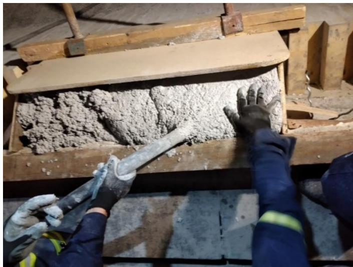
Εικόνα Π.13: Εφαρμογή πυρίμαχης μάζας MAT NANO 80AL/S / Εμφανής θιξοπυρροπία.
