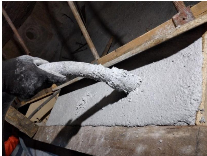
Εικόνα Π.15: Εφαρμογή πυρίμαχης μάζας MAT NANO 75-AL.
