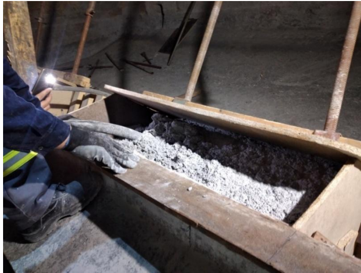
Εικόνα Π.14: Εφαρμογή πυρίμαχης μάζας MAT NANO 75-AL.
