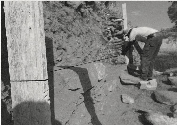
ΕΙΚ.21: Τοποθέτηση ξύλινου οδηγού και νήματος, δημιουργώντας γωνία σε κλίση 3°, 4°, 14°, 22° ή 26° (που αποτελούν τις πιο σύννηθεις κλίσεις τοίχου αντιστήριξης). Η κλίση εξαρτάται από το είδος του εδάφους, το ύψος του τοίχου, την υγρασία και την κλίση των απομεινάντων τοίχων σε περίπτωση ανακατασκευής.
