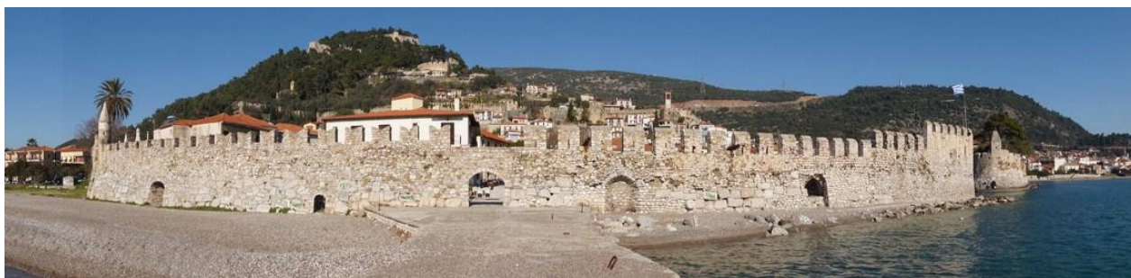
Εικ. 2α), Το λιμάνι: πανοραμική άποψη του ΝΔ λιμενοβραχίονα
