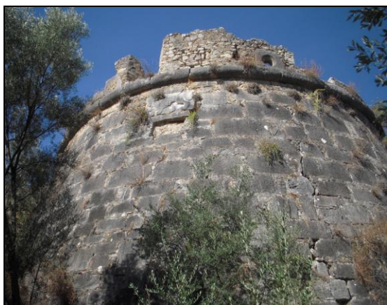
Εικ.13. Ο τεταρτοκυκλικός προμαχώνας της (Φαλτσόπορτας)
