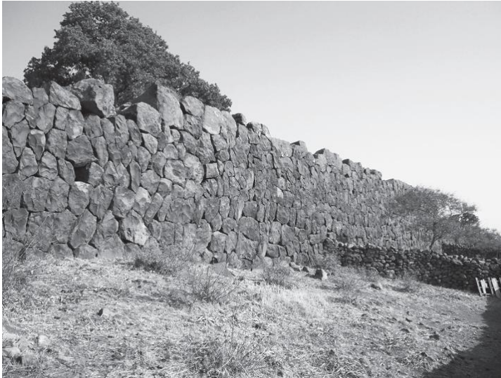
Εικόνα 14 Καλόχτιστας Αποθήκας, με λέσβιο σύστημα δόμησης
