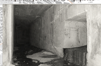
Άποψη υπογειοποιημένου τμήματος
