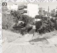
Τα ακρόβαθα της γέφυρας δε φαίνεται να στενεύουν την κοίτη. Όμως, αν όλη βρίσκεται εγκαταλεμένη οικία, εξολοκλήρου κατασκευασμένη μέσα στην κοίτη, παρεμποδίζει σημαντικά την πλημμυρική ροή.
