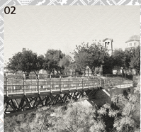
Πρόκειται για μεταλλική γέφυρα που εδράζεται στις στήψεις των πρηνών και δεν επηρεάζει τη ροή του ρέματος.
