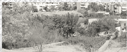
Ιδιωτικές μεταλλικές γέφυρες, εδράζονται στα πρηνά και δεν επηρεάζουν τη ροή του ρέματος.
