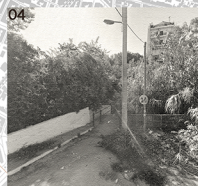
Τα ακρόβαθα της γέφυρας εντοπίζονται στα ανώτερα τμήματα των πρηνών ενώ το μεσοβάθρο εντός της κοίτης. Δε φαίνεται να επηρεάζει τη ροή του ρέματος.
