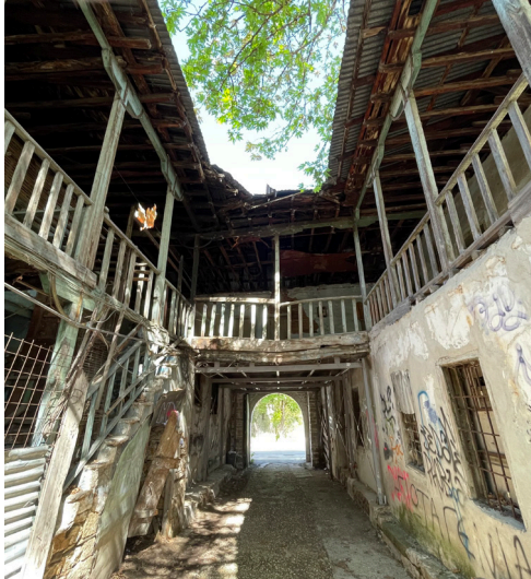
Εικόνα 3: Το χαγιάτι του πρώτου ορόφου.
