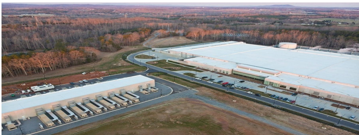
Εικόνα 1.4 – Apple Data Center, Maiden, Βόρεια Καρολίνα, ΗΠΑ [24]
