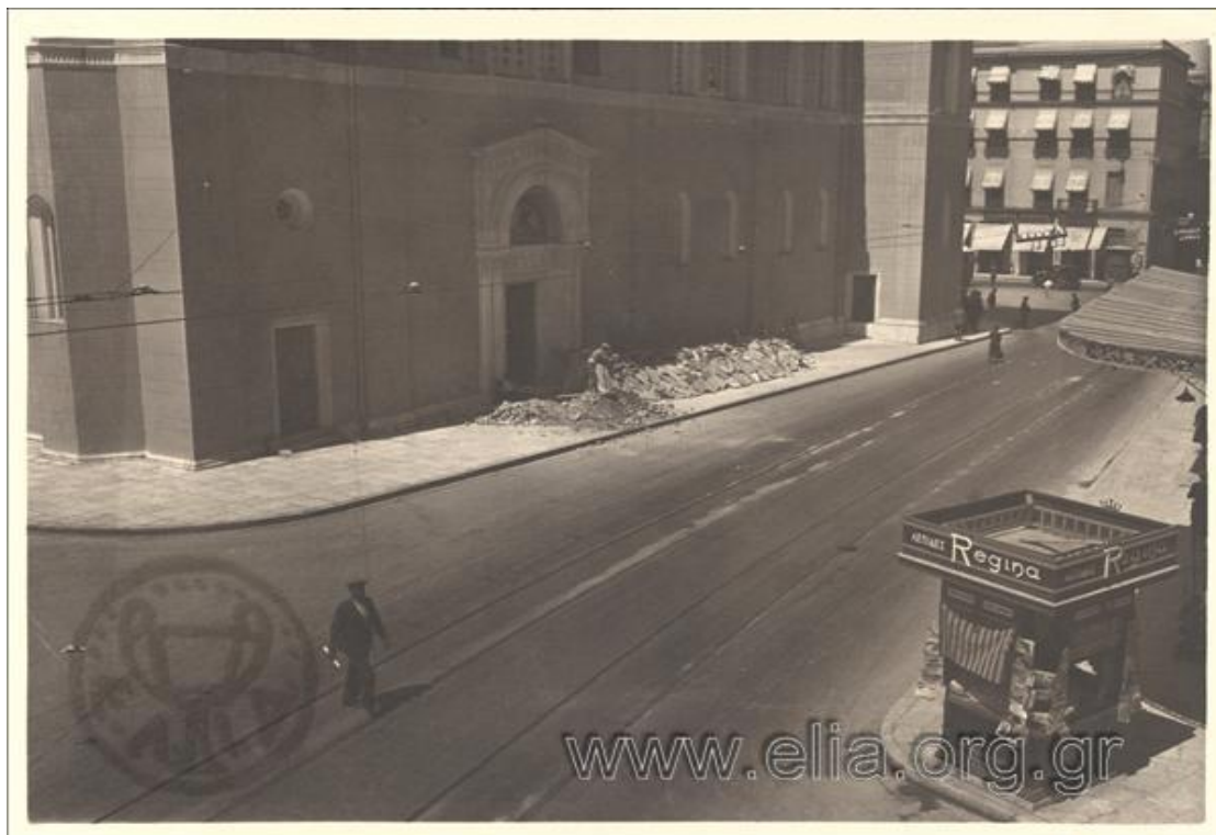
2 Έργα οδοποιίας το 1930 στην οδό Μητροπόλεως. Πηγή: ΕΛΙΑ, Αρχείο Κώστα Κοτζιά,
