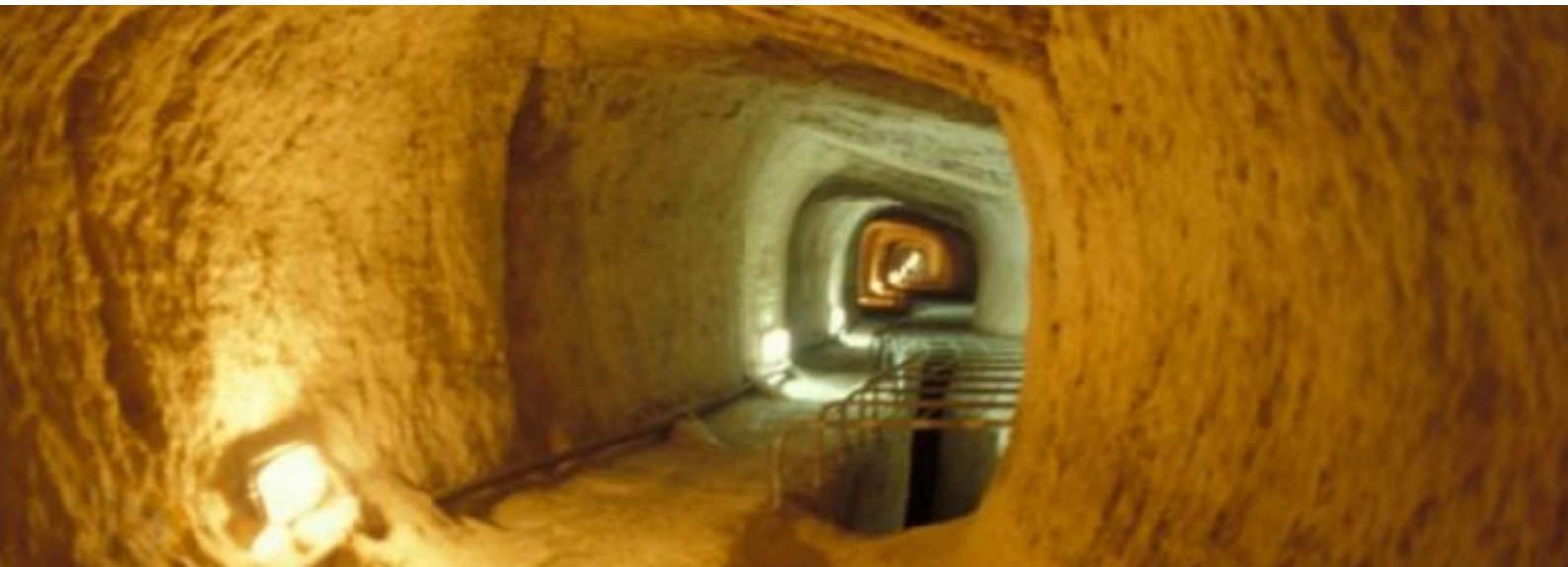
Εικόνα 5: Το Ευπαλίνειο Όρυγμα στη Σάμο αποτελεί εξαιρετικό δείγμα δημόσιας αρχιτεκτονικής και εφαρμοσμένης μηχανικής στην αρχαιότητα. Κατασκευάστηκε ως υπόγεια σήραγγα για την υδροδότηση της πόλης, αποδεικνύοντας την ακρίβεια γεωμετρικού σχεδιασμού, τη συλλογική οργάνωση και τη λειτουργική σύνδεση της αρχιτεκτονικής με τις κοινωνικές ανάγκες.
