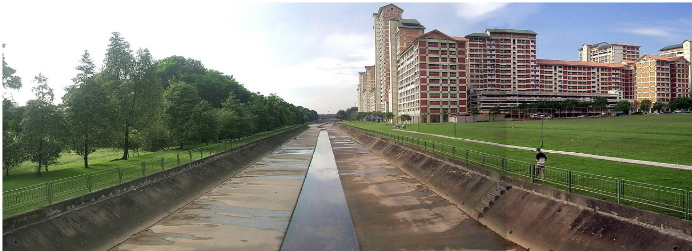
Εικόνα 89: Η προγενέστερη κατάσταση του Kallang River στο Bishan-Ang Mo Kio Park: ένα ευθύγραμμο, τσιμεντένιο κανάλι αποστράγγισης, πλήρως αποκομμένο από τον περιβάλλοντα χώρο. Η εικόνα αποτυπώνει τον αυστηρά μηχανικό χαρακτήρα της αρχικής υποδομής, η οποία στερούνταν οικολογικής λειτουργίας και κοινωνικής προσβασιμότητας.
