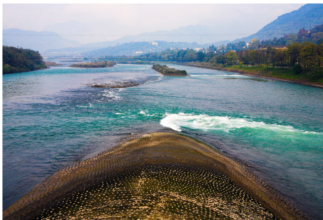
Εικόνα 11: Η κατασκευή του “στόματος του ψαριού” (Fish Mouth Levee) στο Dujiangyan διαχωρίζει τον ποταμό Min σε δύο ροές, επιτρέποντας την υδραυλική ρύθμιση χωρίς φράγμα. Η αρχιτεκτονική μορφή του επιτρέπει τον έλεγχο της παροχής και την αποτροπή πλημμυρών, εφαρμόζοντας αρχές φυσικής ροής και βαρύτητας.
