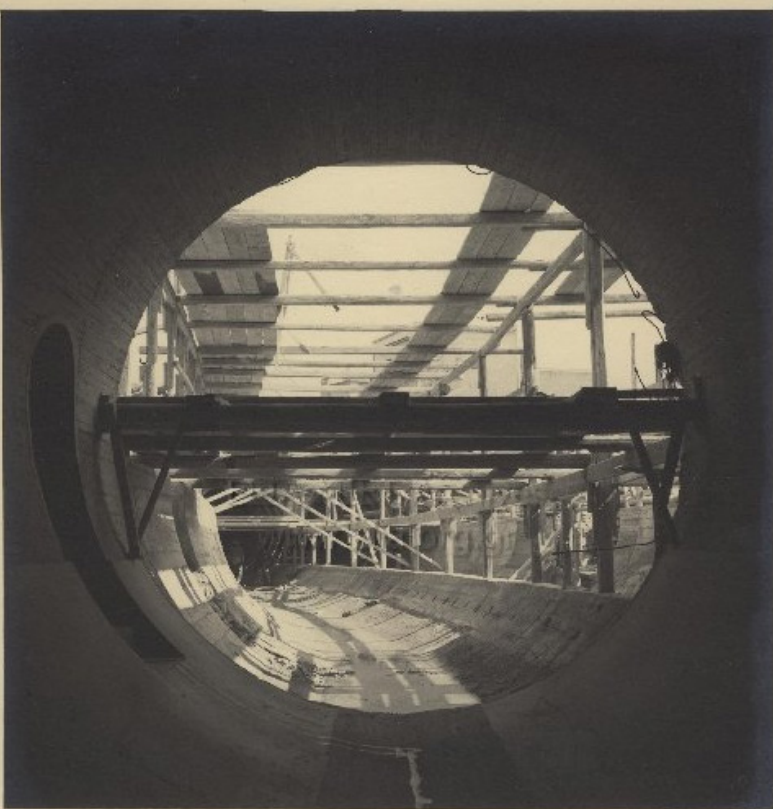
Κατασκευή Δίδυμου Ἀγωγού Ἰλίου.
