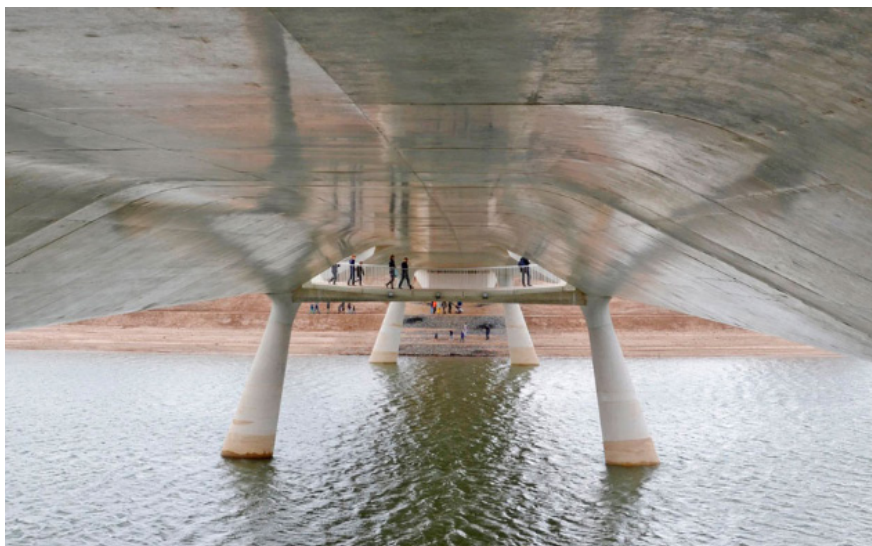
Εικόνα 55: Υποδομή διπλής λειτουργίας στο πλαίσιο του Room for the River στη Νιμέγη: πεζογέφυρα ενσωματωμένη στη δομή υδραυλικής γέφυρας, σχεδιασμένη ώστε να επιτρέπει τη ροή του νερού χωρίς εμπόδια και να διασφαλίζει την προσβασιμότητα των πολιτών. Το παράδειγμα αποτυπώνει τον τρόπο με τον οποίο το πρόγραμμα συνδύασε τεχνική αποδοτικότητα με αστική εμπειρία, μετατρέποντας το υδάτινο τοπίο σε λειτουργικό και κοινωνικά ενεργό χώρο.
