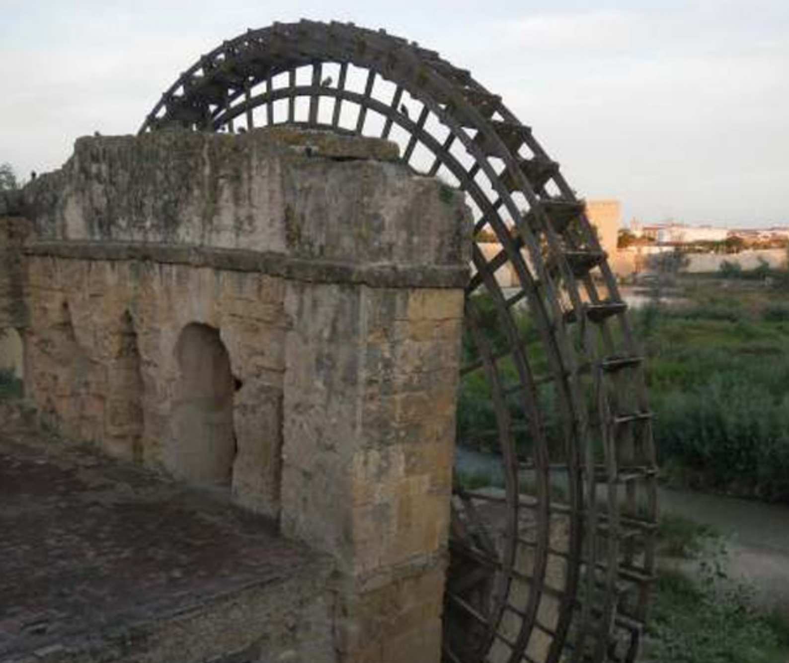
Εικόνα 2: Χαρακτηριστικός νερόμυλος (νουρία) στον ποταμό Γουαδαλκιβίρ στην Κόρδοβα, αρχικά ρωμαϊκής κατασκευής, τροποποιημένος στον Μεσαίωνα για άρδευση και άλεση σιτηρών. Κινούνταν με τη δύναμη του ποταμού, παρέχοντας νερό στους κήπους του Αλκαθάρ ντε λος Ρέγιες Κριστιάνος.
