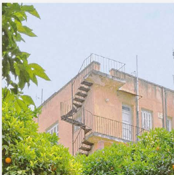
μεταλλικές εξωτερικές σκάλες
