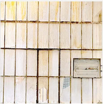
μεταλλικά κουφώματα φωταγωγών
