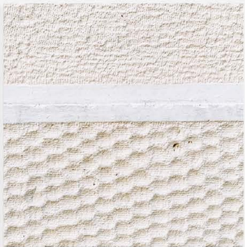
artificiel τεχνοτροπία εξωτερικού τοίχου
