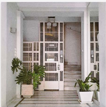
μεταλλικός διάτρητος ανεγκυστήρας
