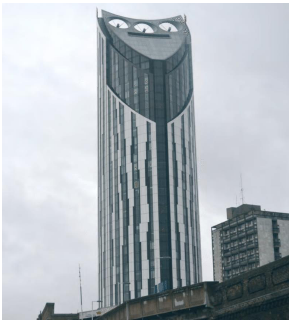
Εικόνα 7: Εφαρμογή ΑΠΕ σε αστικό περιβάλλον – Strata Tower, London (Πηγή: Τσιάρας Ε. Ανακτήθηκε στις 4.11.2024)
