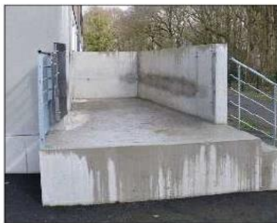
Εικόνα 04.05 Τσιμεντένια αποβάθρα φόρτωσης σε εκτροπή η οποία διευκολύνει τις διαδικασίες φόρτωσης.
