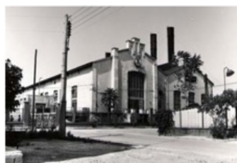
Εικόνα (47-48): Το εργοστάσιο κατά τη περίοδο 1889-1940/50
