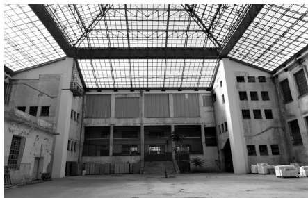
Εικόνα (37) : Το Καπνεργοστάσιο κατά τη διάρκεια εργασιών
