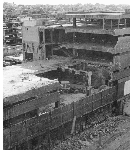
Εικόνα (15) : Η κατεδάφιση του μισού κτιρίου το 1995
