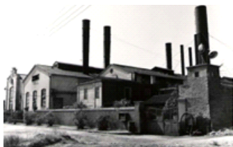
Εικόνα (46): Το εργοστάσιο κατά τη περίοδο 1889-1940/50
