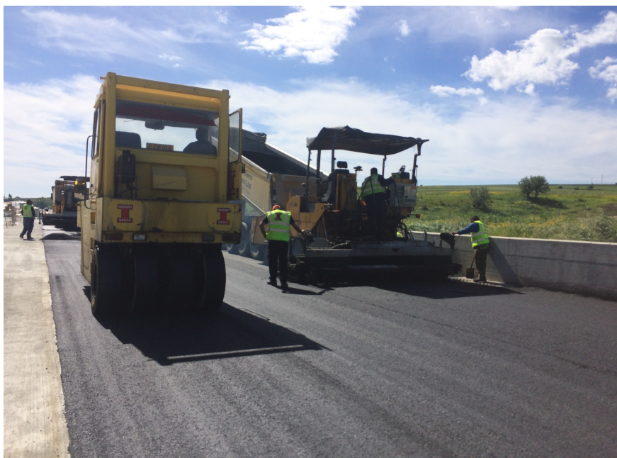
Εικόνα 4: Συμπύκνωση-διάστρωση ασφαλτικού
