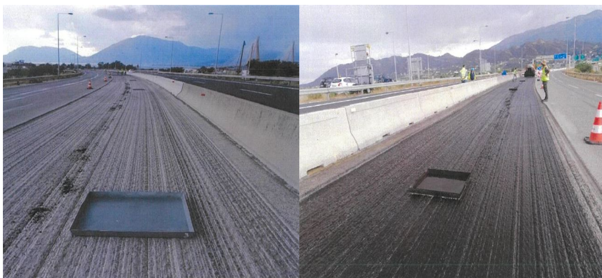
Εικόνα 10 : Οδόστρωμα πριν και μετά την εφαρμογή συγκολλητικής επάλειψης
