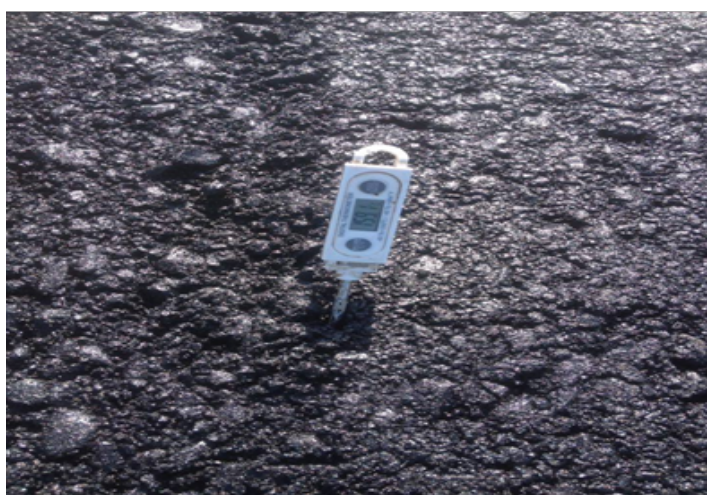
Εικόνα 1: Μέτρηση θερμοκρασίας ασφαλτομίγματος κατά τη διάστρωση
