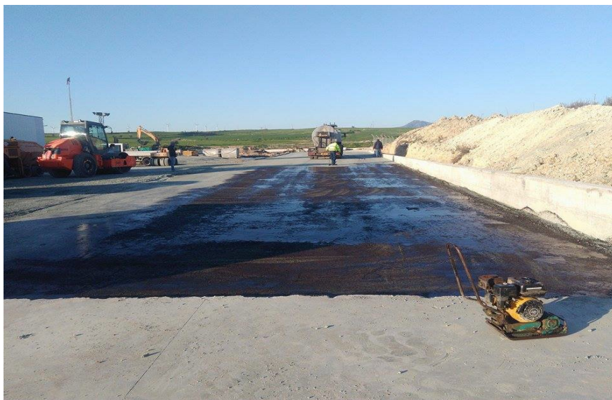
Εικόνα 3: Ασφαλτική προεπάλειψη σε υλικό βάσης
