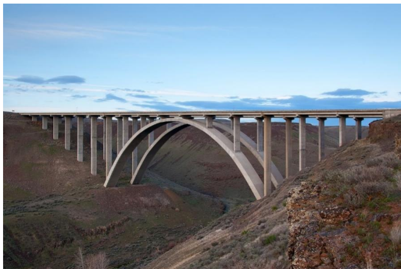
Εικόνα 1. Fred G. Redmon Bridge, τσιμεντένια γέφυρα του 1971 στην Yakima County, Washington [41].
