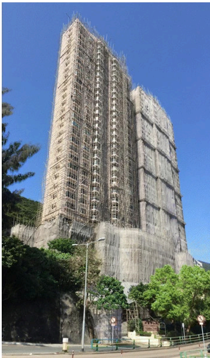
Εικ.13: Μπαμπού δεμένο στο χέρι που χρησιμοποιείται ως τυπική προσωρινή σκαλωσιά στο Χονγκ Κονγκ.
