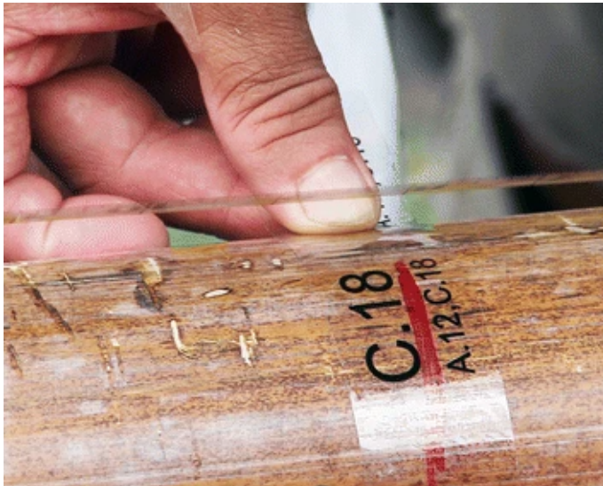
Εικ.21: Οι αυτοκόλλητες ετικέτες με πληροφορίες σύνδεσης τοποθετούνται χρησιμοποιώντας μια μεζούρα
