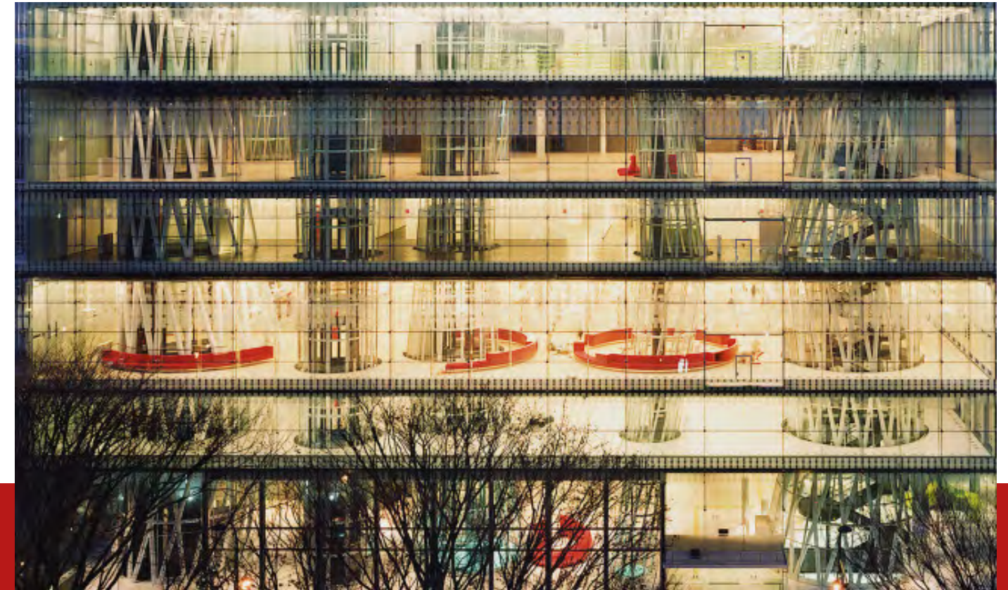
Εικόνα 27 : Η πρόσοψη του κτιρίου κατά τη διάρκεια της ημέρας, όπου αποκαλύπτεται η σχέση μεταξύ των κάθετων στηλών και των ευρύχωρων εσωτερικών χώρων
