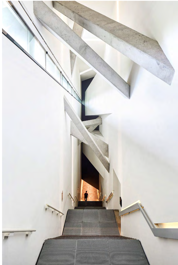
Εικόνα 61 : Εσωτερικός χώρος, με τις γωνιώδεις τσιμεντένιες δοκούς να δημιουργούν ένταση και αποσύνδεση
