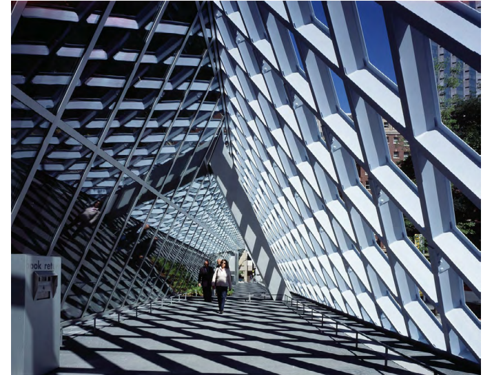
Εικόνα 45 : Εσωτερικός διάδρομος, όπου το φυσικό φως και οι σκιές δημιουργούν ρυθμό
