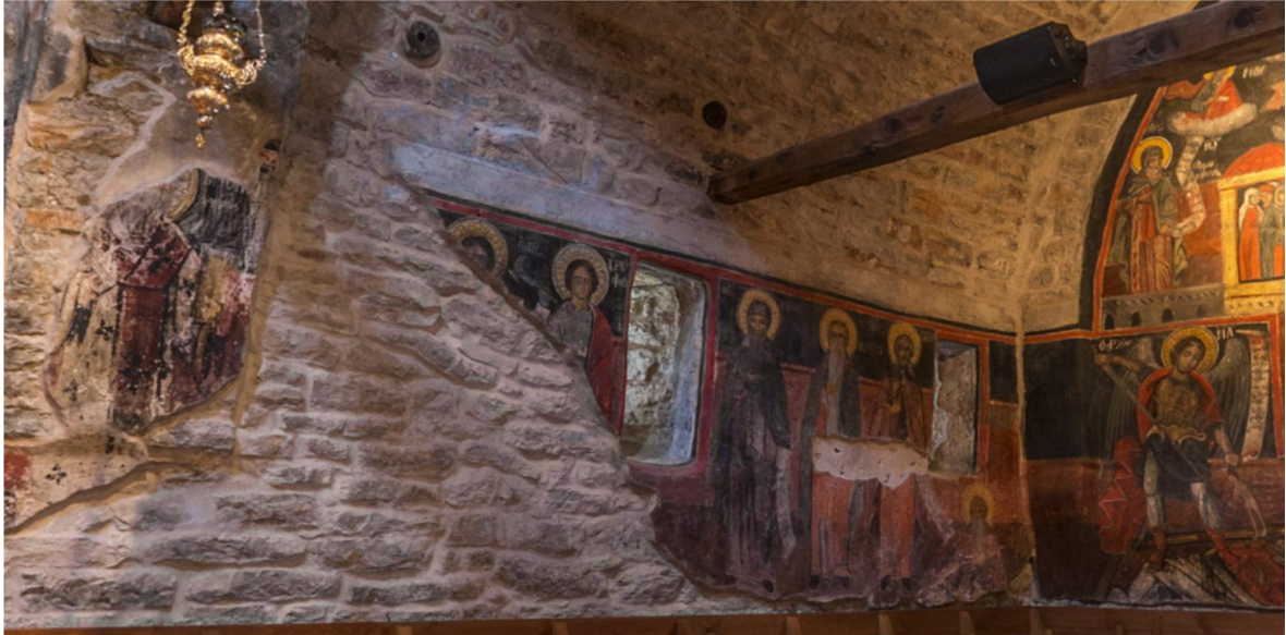
Εικόνα 8. Άποψη του νότιου τοίχου (Κανέλης, Ιερά Μονή, εικ.32)
