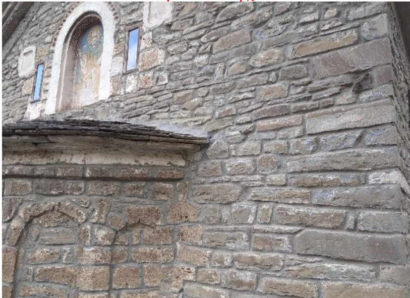
Εικόνα 5. Αποψη της ανατολικής πλευράς. Διακρίνεται το 1700 (προσωπικό αρχείο)
