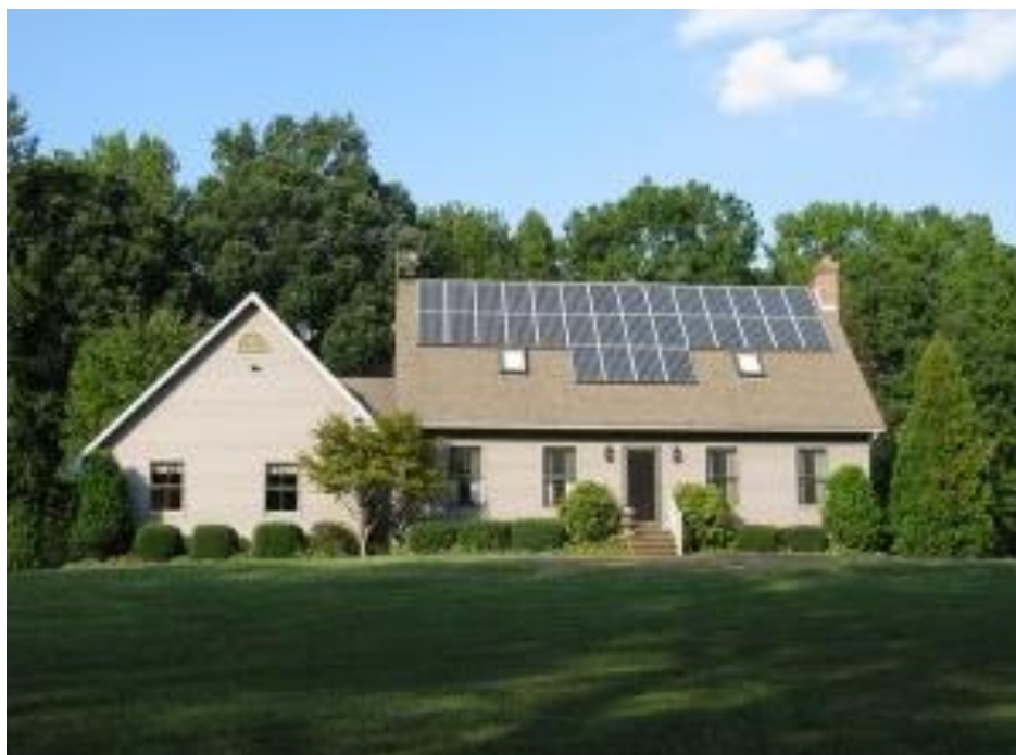
Εικόνα 1.1.4 [2] Ενεργειακά αυτόνομη κατοικία με ηλιακά πάνελ [9]
