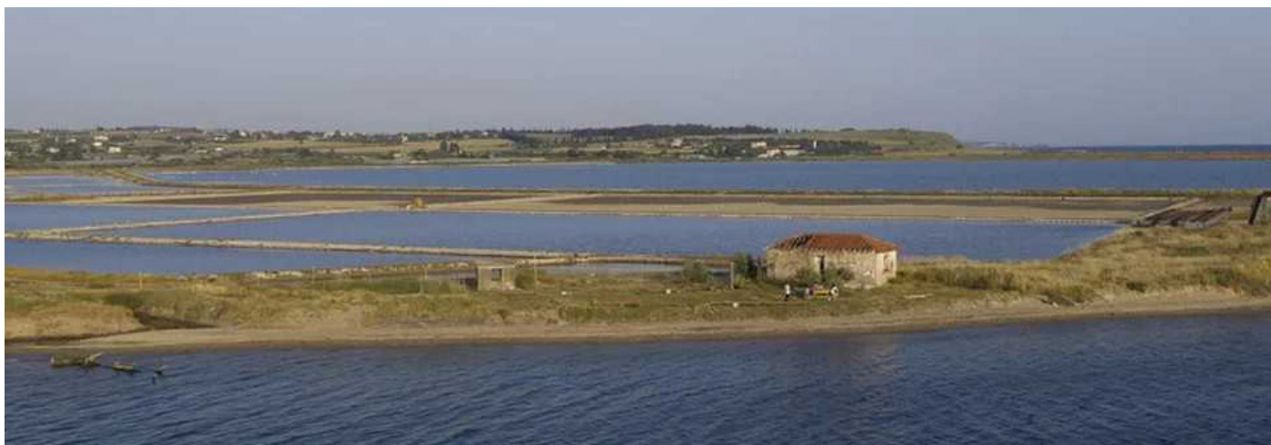
12. Σπίτι του Φύλακα της Αλυκής στη λιμνοθάλασσα Αγγελοχωρίου.
