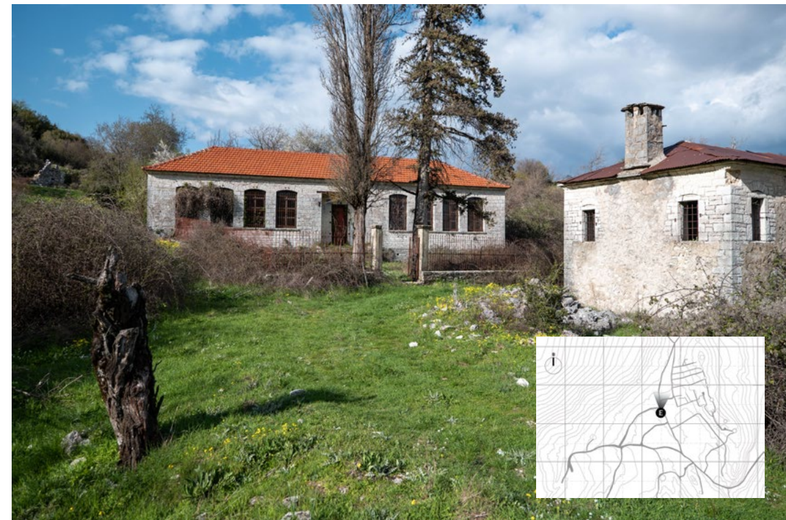
Ε Σχολείο | 07 Απριλίου '23
