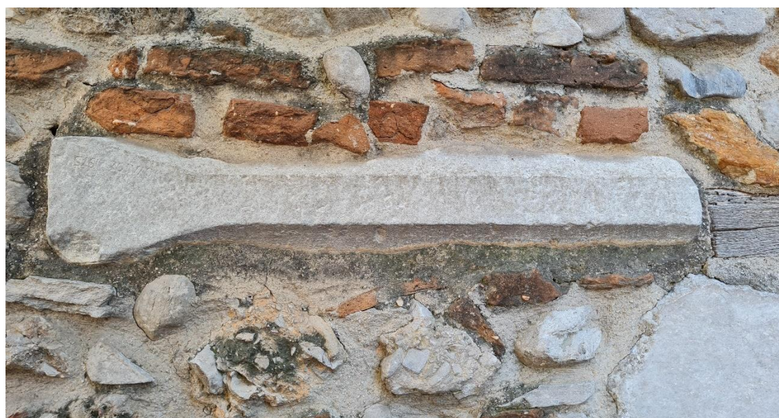
59. Τμήμα οκταγωνικού κιονίσκου με συμφυές τεκτονικό κιονόκρανο (βόρεια πλευρά)
