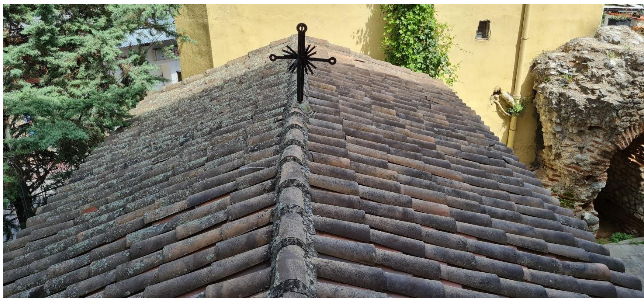
11. Η δίριχτη στέγη του ναού
