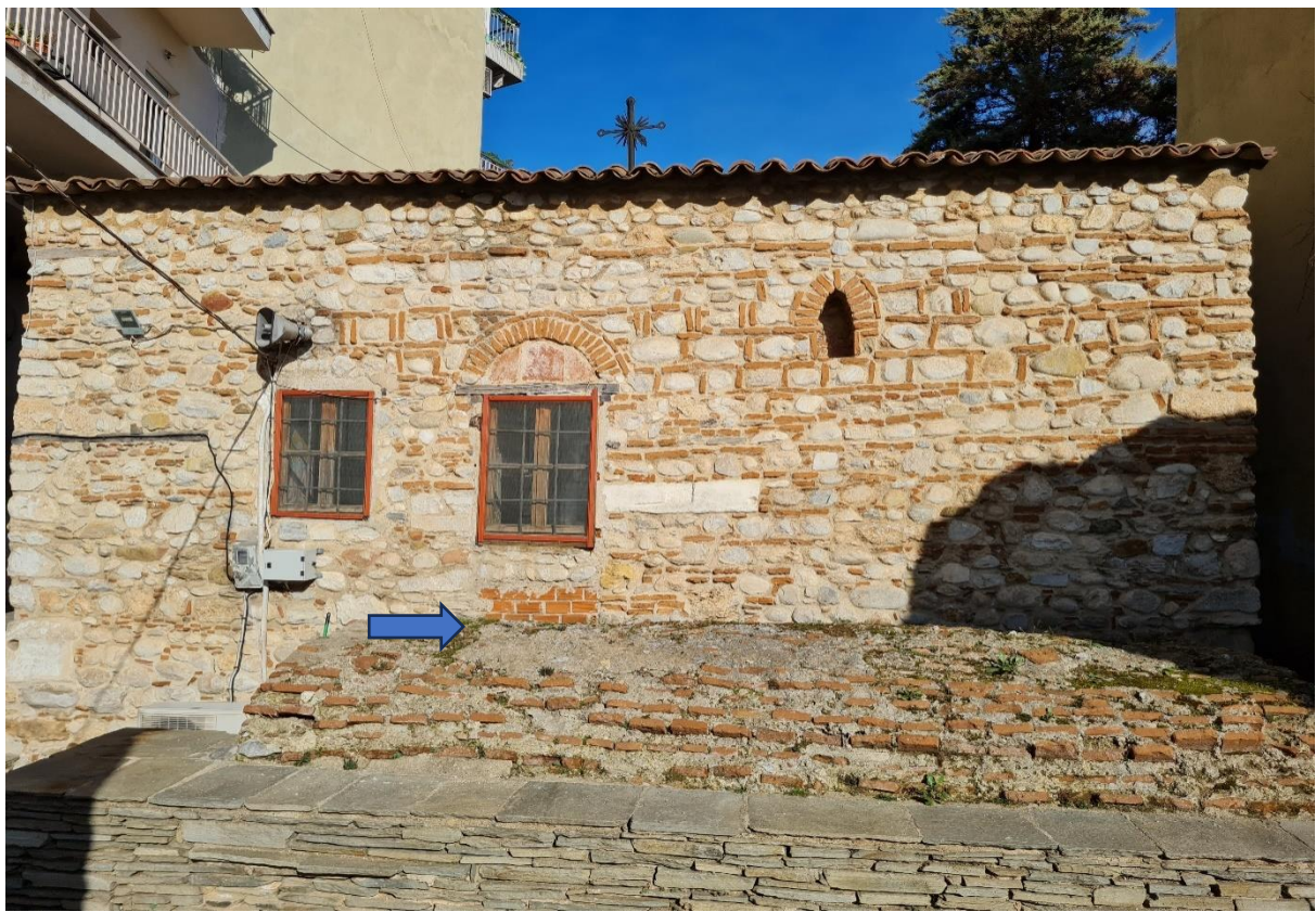
13. Η νότια πλευρά του ναού, όπου και η αρχική νότια είσοδος (διακρίνεται ο εντοιχισμός της κάτω από το επιστεφόμενο με πλίνθινο τόξο παράθυρο)
