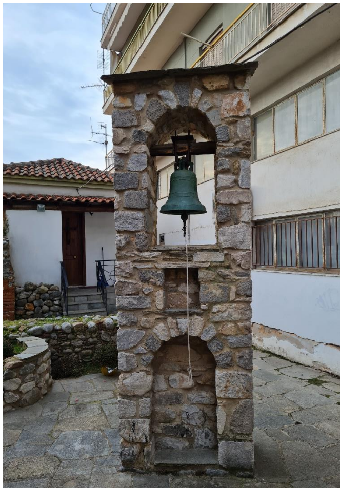
49. Το υπάρχον καμπαναριό στη νοτιοδυτική πλευρά της αυλής
