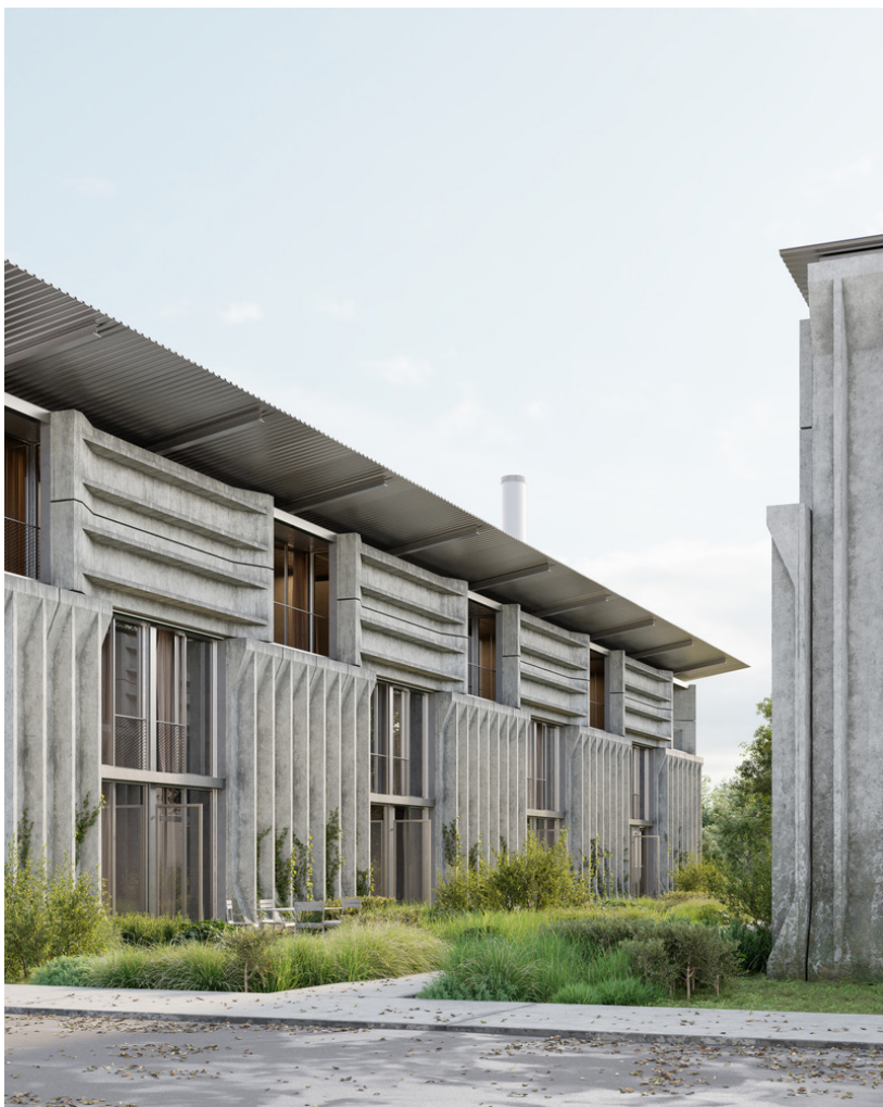
Εικόνα 17. Πλάκες από το χώρο στάθμευσης ως στοιχείο της όψης
