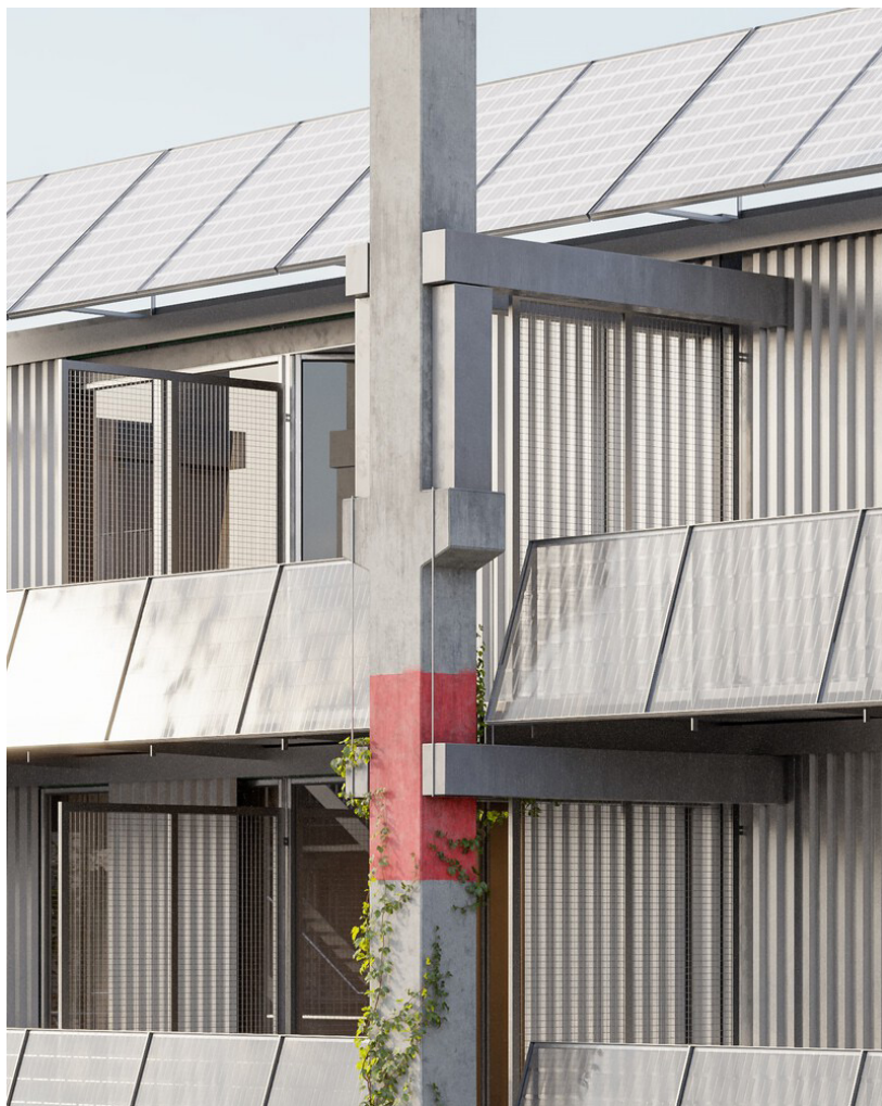
Εικόνα 16. Δομικό στοιχείο από το χώρο στάθμευσης ως στοιχείο της όψης
