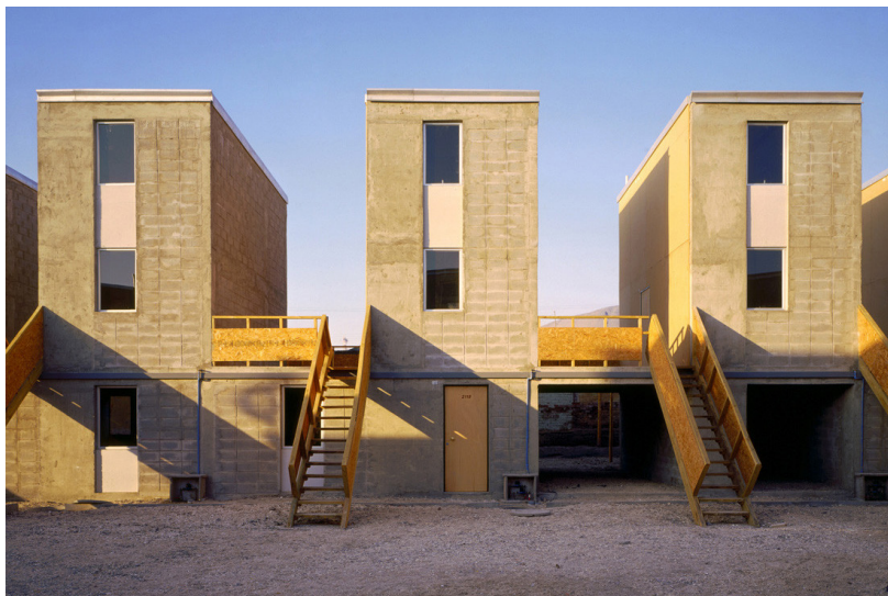
Εικόνα 19. Κατοικίες Quinta Monroy
