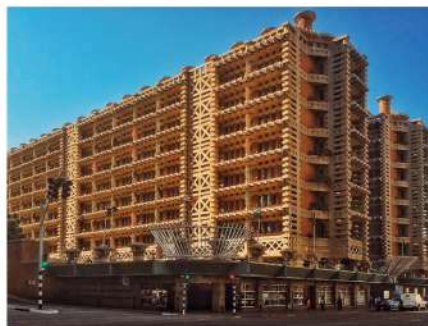
Εικόνα 30: Το Eastgate Center του οποίου η δομή είναι εμπνευσμένη από τη λειτουργία των τύμβων των τερμιτών. (Watch how the Eastgate Center in Zimbabwe Cools Itself Without Air Conditioning, 2018, https://livinspaces.net/ls-tv/watch-how-the-eastgate-center-in-zimbabwe-cools-itself-without-air-conditioning/ )
