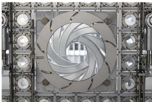
Εικόνα 24: Η εικόνα δείχνει εστιασμένα τη μορφή από ένα από τα παράθυρα του κτιρίου. Το σχήμα του φακού στα παράθυρα είναι μεταβαλλόμενο ανάλογα με τη ποσότητα φωτός που είναι επιθυμητή να εισέλθει εντός του κτιρίου. (Tim Winstanley, ArchDaily, AD Classics: Institut du Monde Arabe / Enrique Jan + Jean Nouvel + Architecture-Studio, https://www.archdaily.com/162101/ad-classics-institut-du-monde-arabe-jean-nouvel )
