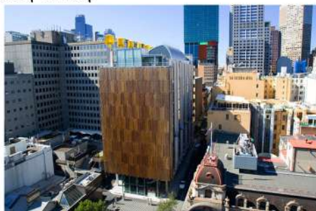
Εικόνα 31: Το κτίριο CH2 διαθέτει σύστημα εξαερισμού εμπνευσμένο από το φυσικό μηχανισμό εξαερισμού στους τύμβους. (Council House 2 (CH2) Melbourne, Australia, basillabs, https://quantifyplacemaking.org/2021/02/15/melbourne.html )
