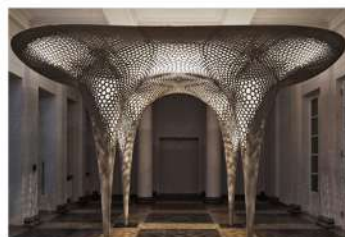
Εικόνα 19: Το Rosenstein Pavilion κατασκευασμένο με βάση τη δομή του οργανισμού του αχινού. (Biomimetics for Architecture: Learning from Nature, Jan Knippers, Ulrich Schmid, Thomas Speck )
