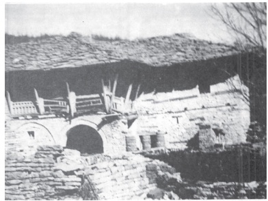
Εικόνα 36, Άγνωστη ερειπωμένη κατοικία Ζαγορίου
