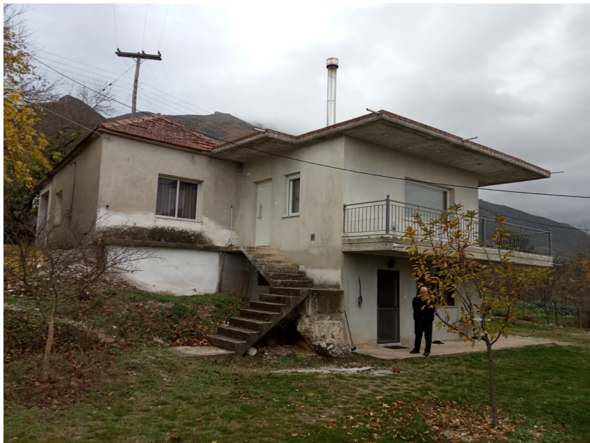
Εικόνα 50, Αποψη της κατοικίας εντός του οικοπέδου
