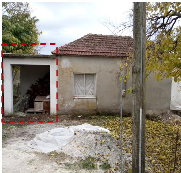
Εικόνα 62, Υφιστάμενη κατάσταση προσθήκης
