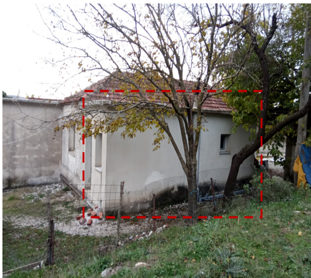
Εικόνα 61, Υφιστάμενη κατάσταση προσθήκης
