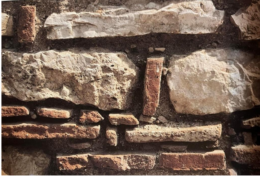
Εικόνα 103: Μ. Ντίλιου, λεπτομέρεια τοιχοποιίας
