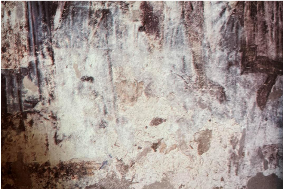
Εικόνα 138: Λεπτομέρεια νότιου τοίχου του καθολικού
