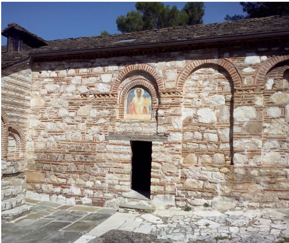
Εικόνα 106: Μ. Ντίλιου, άποψη νότιου τοίχου
