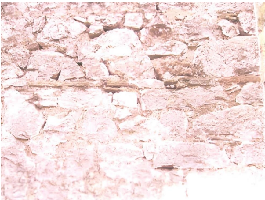
Εικόνα 118: Μονή Προφήτου Ηλίου. Λεπτομέρεια τοιχοποιίας του βόρειου μακρού τοίχου
