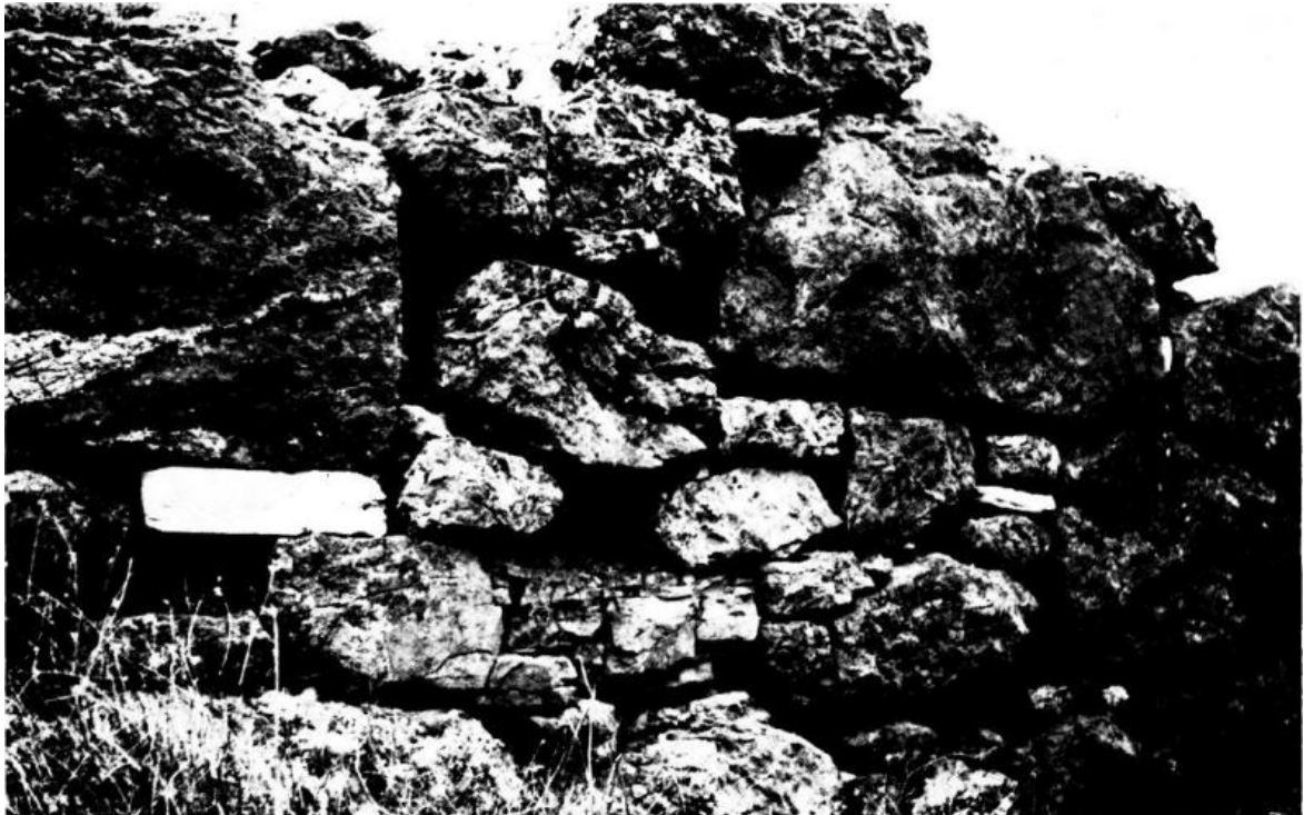
Εικ. 84: Η αργολιθοδομή του μεσοπυργίου διαστήματος μεταξύ των πύργων VIII και IX (Mussche 1964, 431, εικ. 8).
