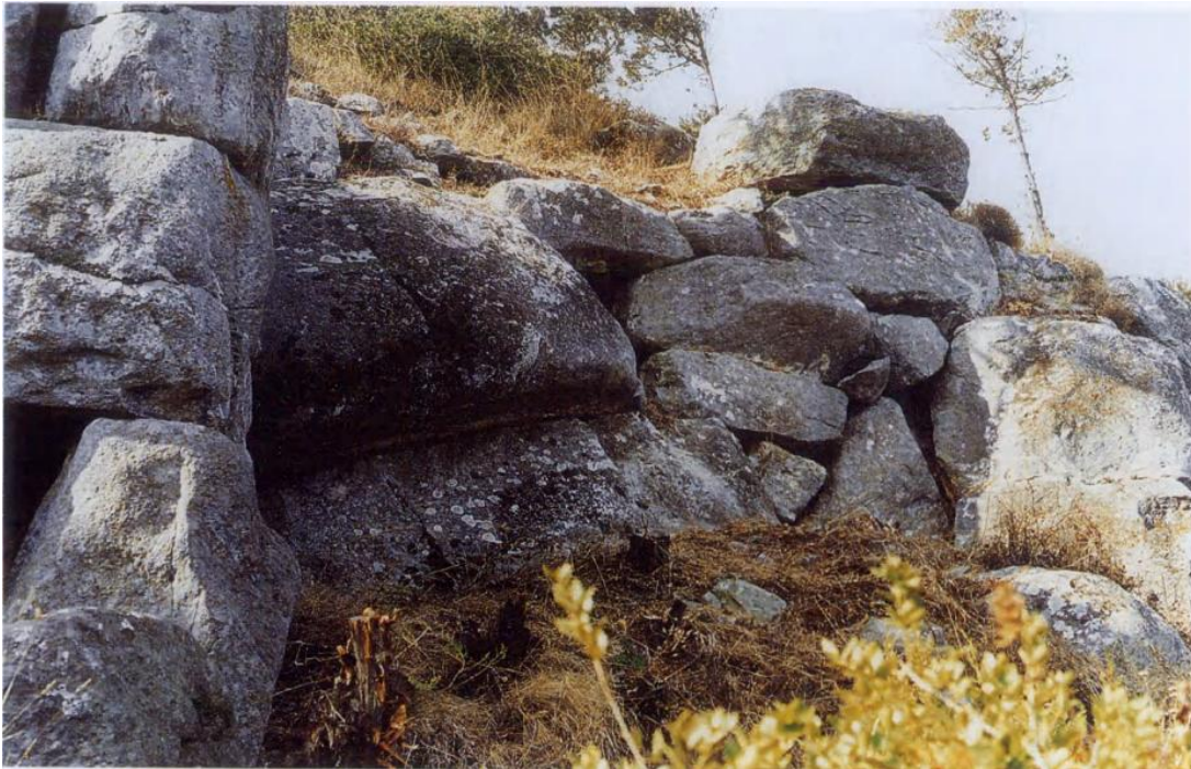
Εικ. 68: Τμήμα του πύργου Μ και του βορείου σκέλους του φρουρίου (Πετράκος 1999α, 72, εικ. 31).
