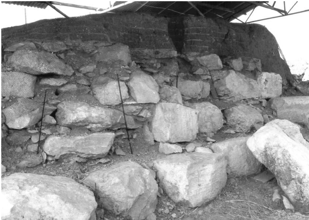
Εικ. 26: Αρχιτεκτονικά λείψανα του πύργου Α και της πλίνθινης ανωδομής του (Δεκουλάκου 2008, 11, εικ. 2).
