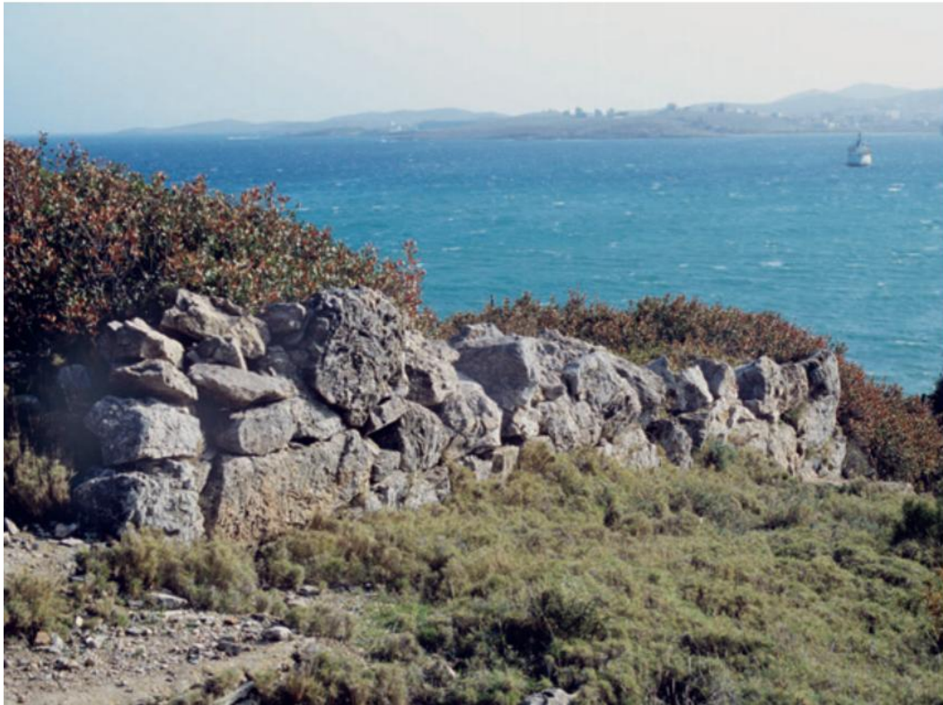
Εικ. 59: Τμήμα του ανατολικού σκέλους της παραθαλάσσιας φρουριακής εγκατάστασης (Lohmann 2021, 111, εικ. 64).
