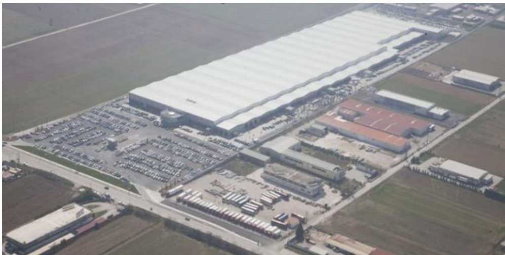
Εικόνα 2.1 Στην "καρδιά" του logistics center της Διαμαντής Μασούτης Α.Ε. στο Καβαλάρι Θεσσαλονίκης (Πηγή iefimerida, 2019)
