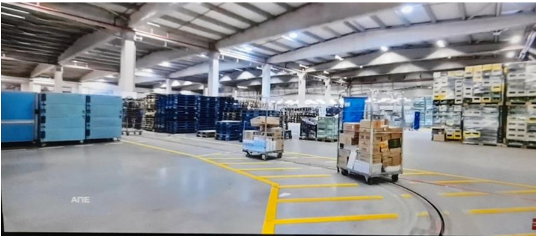
Εικόνα 2.2 Ενδοδαπέδια αλυσίδα μεταφορών στο logistics center της Διαμαντής Μασούτης Α.Ε. (Πηγή φωτογραφία από βίντεο που προβλήθηκε στο Αθηναϊκό Μακεδονικό Πρακτορείο Ειδήσεων)
