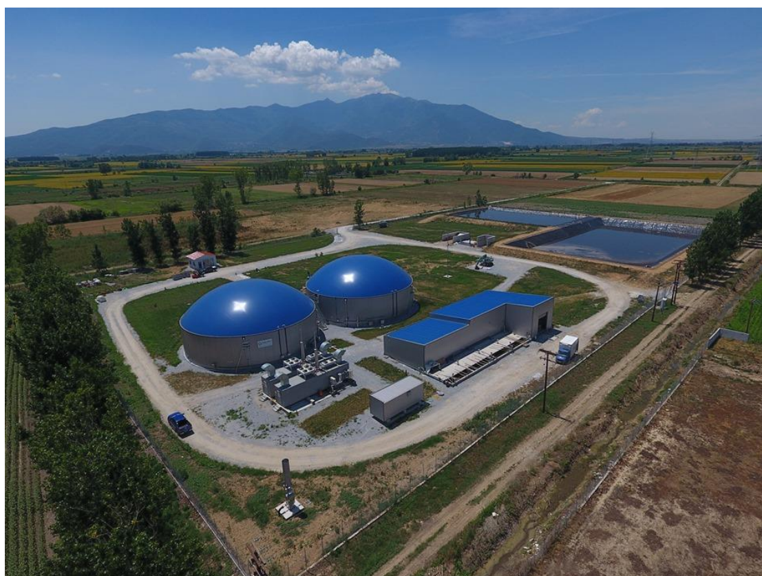
Εικόνα 9: Πανοραμική άποψη μονάδας βιοαερίου ( www.heliotop.gr ).
