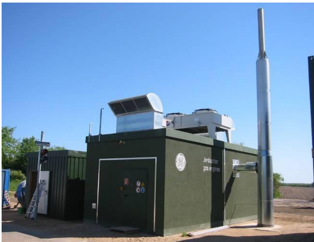
Εικόνα 21: Μηχανή εσωτερικής καύσης βιοαερίου άνω των 4.000Volt. (Παπαζηλάκης, 2013).
