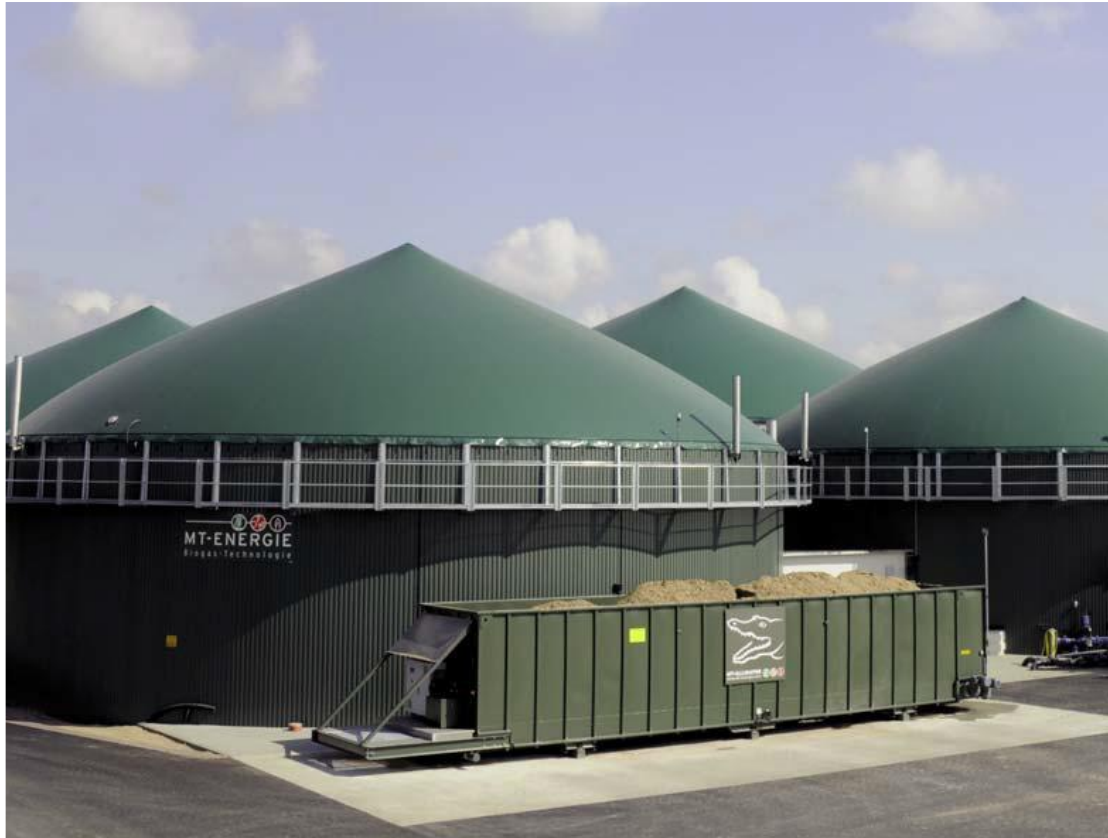
Εικόνα 13: Αναερόβιοι αντιδραστήρες με δεξαμενή αποβλήτων στερεών τύπου κοντέινερ (Παπαζηλάκης, 2013).
