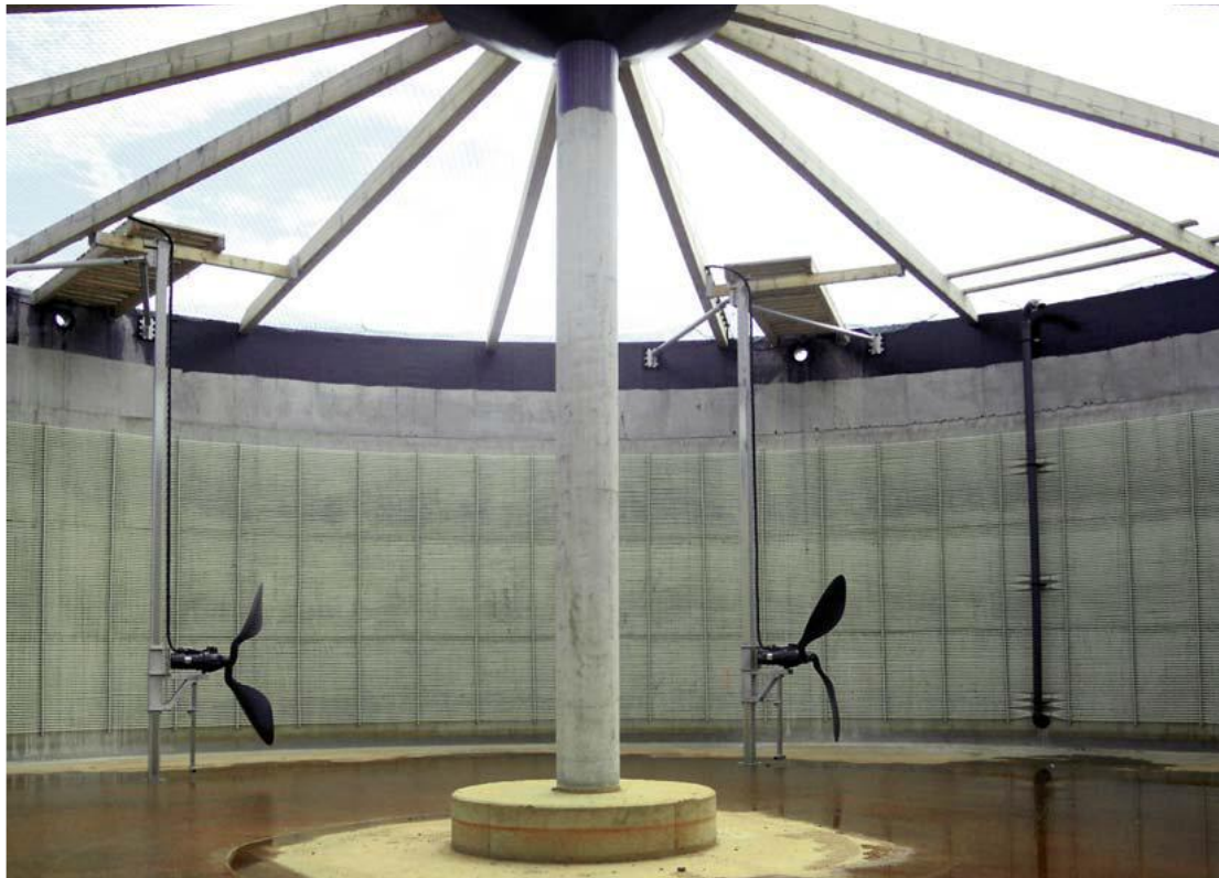
Εικόνα 12: Μηχανικός αναδευτήρας με ενσωματωμένο μοτέρ (Παπαζηλάκης, 2013).
