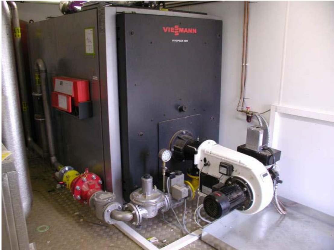
Εικόνα 22: Καυστήρας βιοαερίου για παραγωγή θερμότητας (Rutz D et al., 2008).
