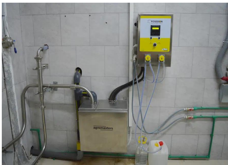
Εικόνα 22. Πλυντήριο αρμεκτηρίου
