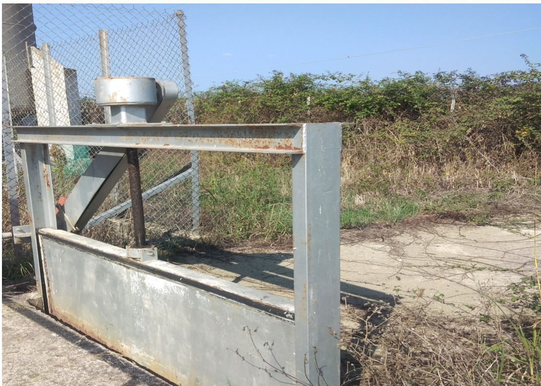
Εικόνα 10. Πόρτα εισόδου ύδατος Αντλιοστασίου Βαλανιδοράχης
