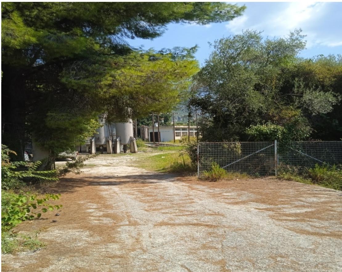
Εικόνα 4. Το Αντλιοστάσιο Γλυκής
